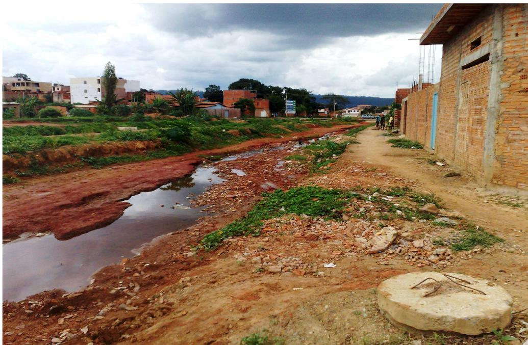
**Figura 46 – Rua sem pavimentação com água empoçada após transbordamento do canal pluvial com esgoto e lixo no bairro São Judas Tadeu**
