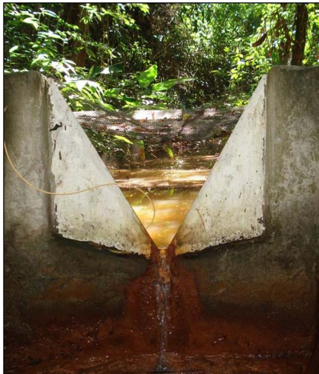
Figura 4.10 – Imagem do vertedouro da microbacia Milagres.
