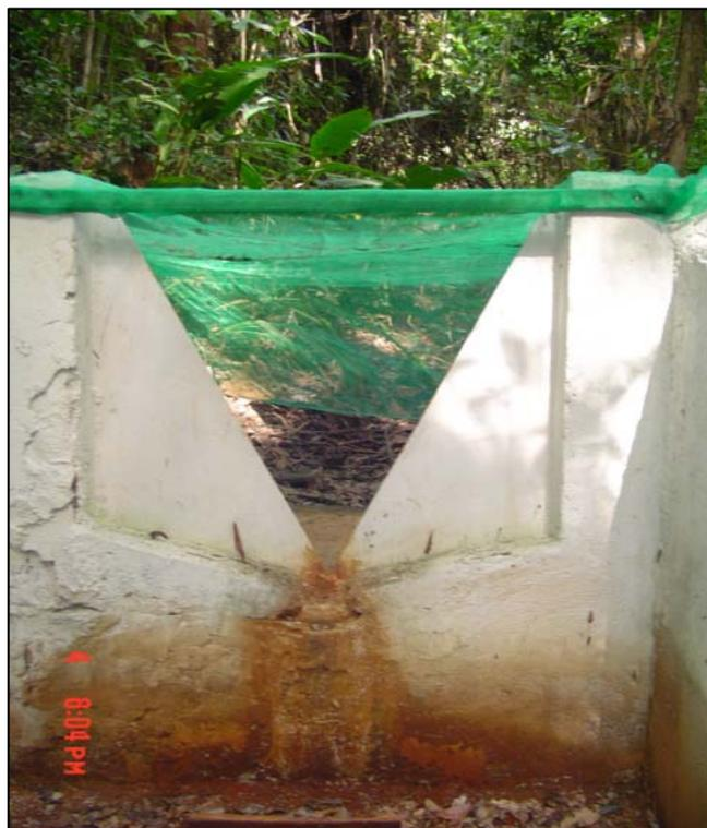
Figura 4.15 – Vertedouro da microbacia Milagres, mostrando que não estava vertendo água.
