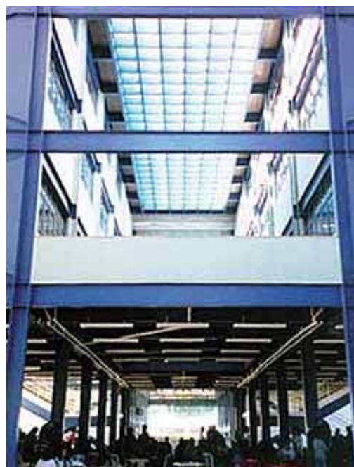
Figura 5. 13 Vazio interno ventilado. (Autora)
