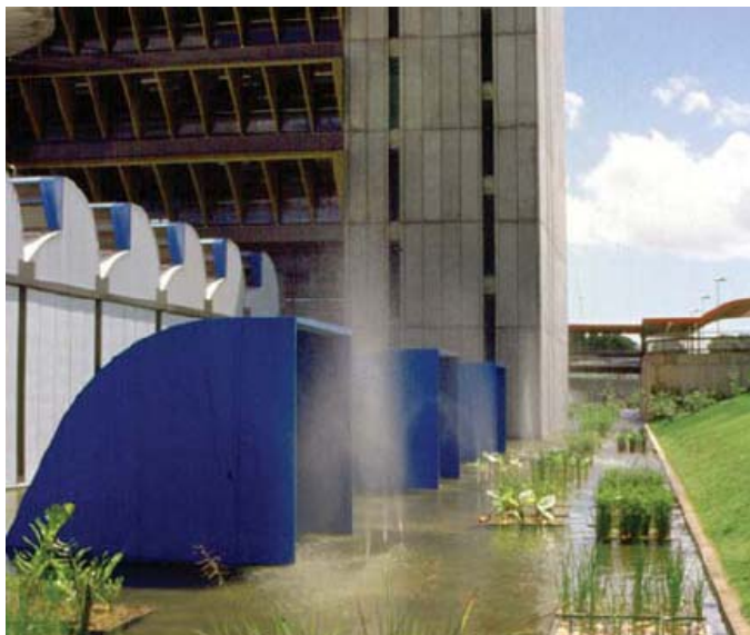
Figura 3. 5 entradas de ar das galerias de ventilação subterrâneas (MONTERO, 2006).
