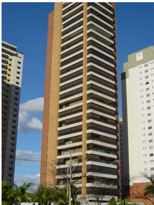
Figura 5. 10 Fachadas Norte e Oeste Edifício Place des Vosges. (Autora)
