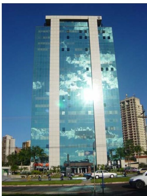
Figura 5. 14 Fachada Noroeste. (Autora)
