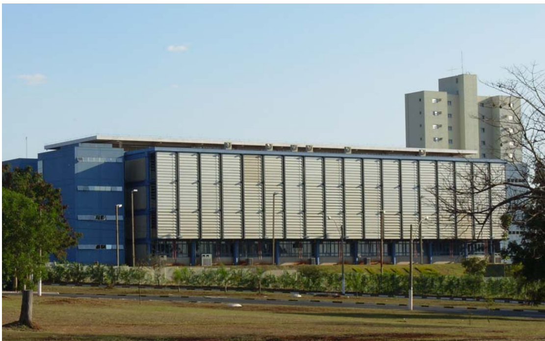
Figura 5. 11 Fachada Nordeste Edifício 1 da UNIP. (Autora)
