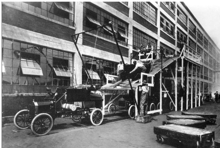
**Figura 2-1** - Linha de montagem do Ford Modelo T. Fonte: Wikipedia Assembly Lines.
