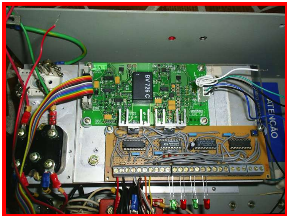
Figura 4.25. Driver SKH10 + Proteção Contra Sobretensão + Semicondutores de Potência
