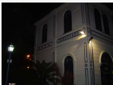
Fig.67 – Prédio da Estação Inicial: pouca iluminação
