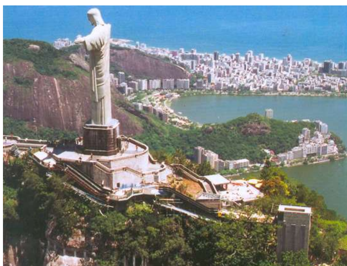
Figuras 43 e 44 – Visão geral do monumento e melhorias após o projeto Cristo Redentor: esquema de corte lateral e foto após a conclusão. Fonte: FUNDAÇÃO ROBERTO MARINHO, 2005.
