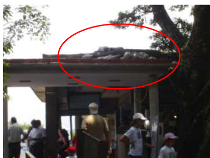
Fig. 74 – Base da escadaria: Inadequação de locação do material de obra.
