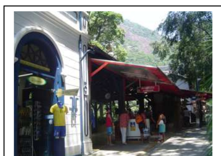
Fig.59-Estação Inicial e cobertura anexa Incompatibilidade e inadequação com o prédio histórico.
