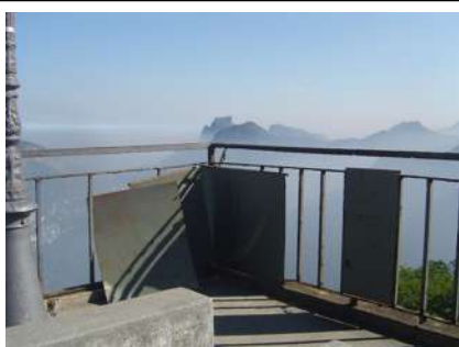
Fig. 78- Guarda-corpo no Estacionamento: corrosão na estrutura metálica e placas metálicas soltas
