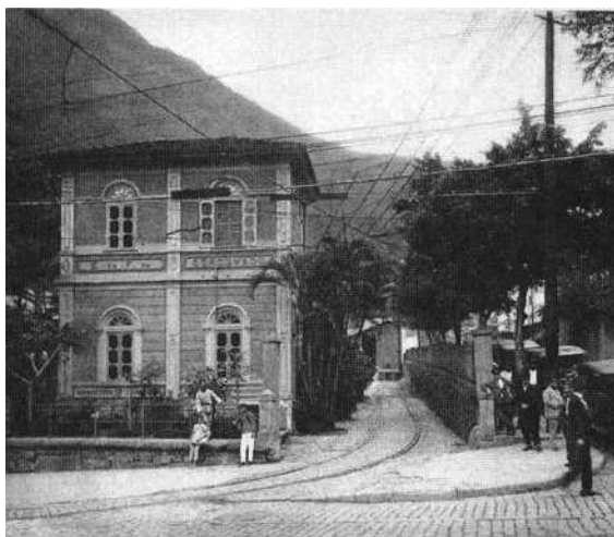
Figura 9 – Vista do Estação inicial em 1884. Fonte: RUBINSTEIN, 1999.
