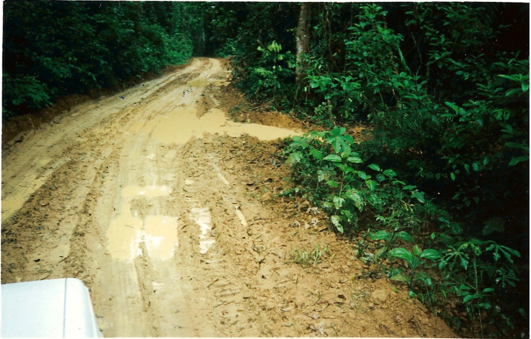
Figura 12: Trecho de estrada em projeto de assentamento de Marabá, no ano de 2004.
