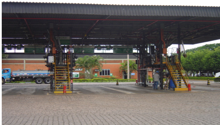
Figura 2 - Vista da plataforma de carregamento de um terminal Fonte: Arquivo do autor
