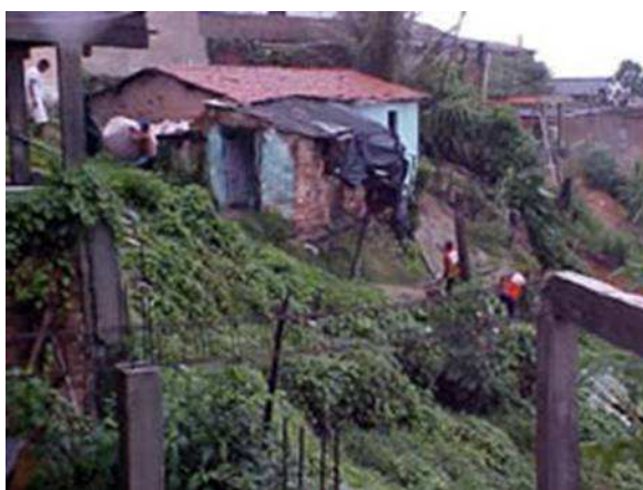
Foto 7 - Cheia no município de Cabo de Santo Agostinho, junho/2005. Fonte: CABO DE SANTO AGOSTINHO, 2005.
