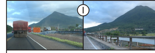
Km 221 - Obras de duplicação
