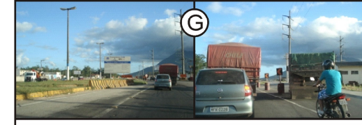
Km 219 - Ponto inicial das obras de duplicação
