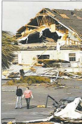
UMA CASA destruída em The Villages, na Flórida: marcas do tornado
