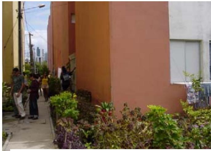
Foto 4 –Projeto Beira Rio –Recife – Conjunto Beira Rio–Construção habitacional na área de reassentamento.
