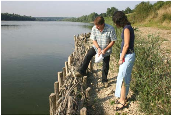
Figura 3.11a. Técnica vegetal de contenção de encosta (fascine), logo após a intervenção; Rio Loire.
