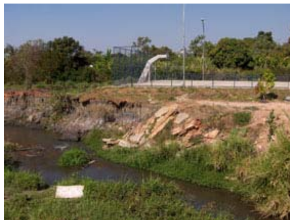
Fig. 6.9. Quadra de esportes, ao lado da ponte Boca Louca, construída na beira do Riacho Fundo.
