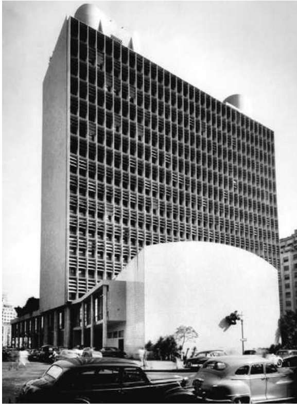
01.O MESP, atual Palácio Capanema. Articulação entre ordenação clássica e linguagem moderna. O edifício evoca natureza de monumentalidade no tecido urbano. Fonte: COMAS (2002) apud CZAJKOWSKI, Jorge (1999).p.99.
