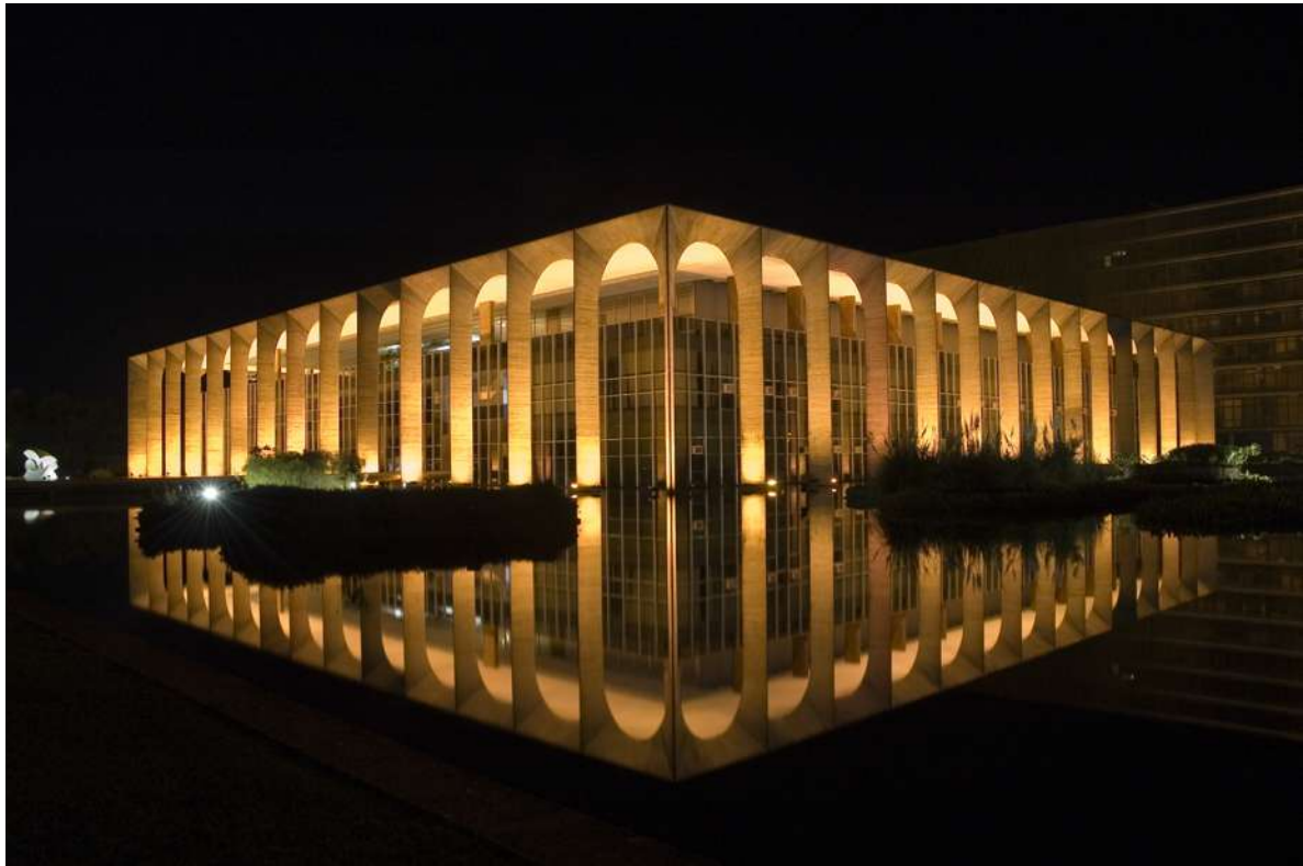
04. Vista noturna do Palácio do Itamaraty. Técnica, desenho e forma convergem para a integridade do edifício. Foto: Joana França, 2002
