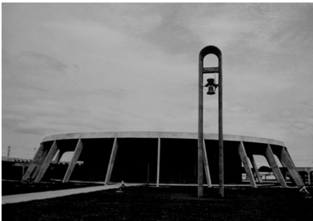
20. Oratório do Soldado, vista externa. Fonte: Arquivo do arquiteto.
