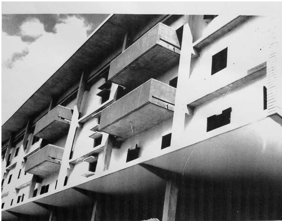
09. Edifícios RE, SQN 407 e 408 (1966). Milton Ramos. Fonte: Milton Ramos, arquivo pessoal do arquiteto .
