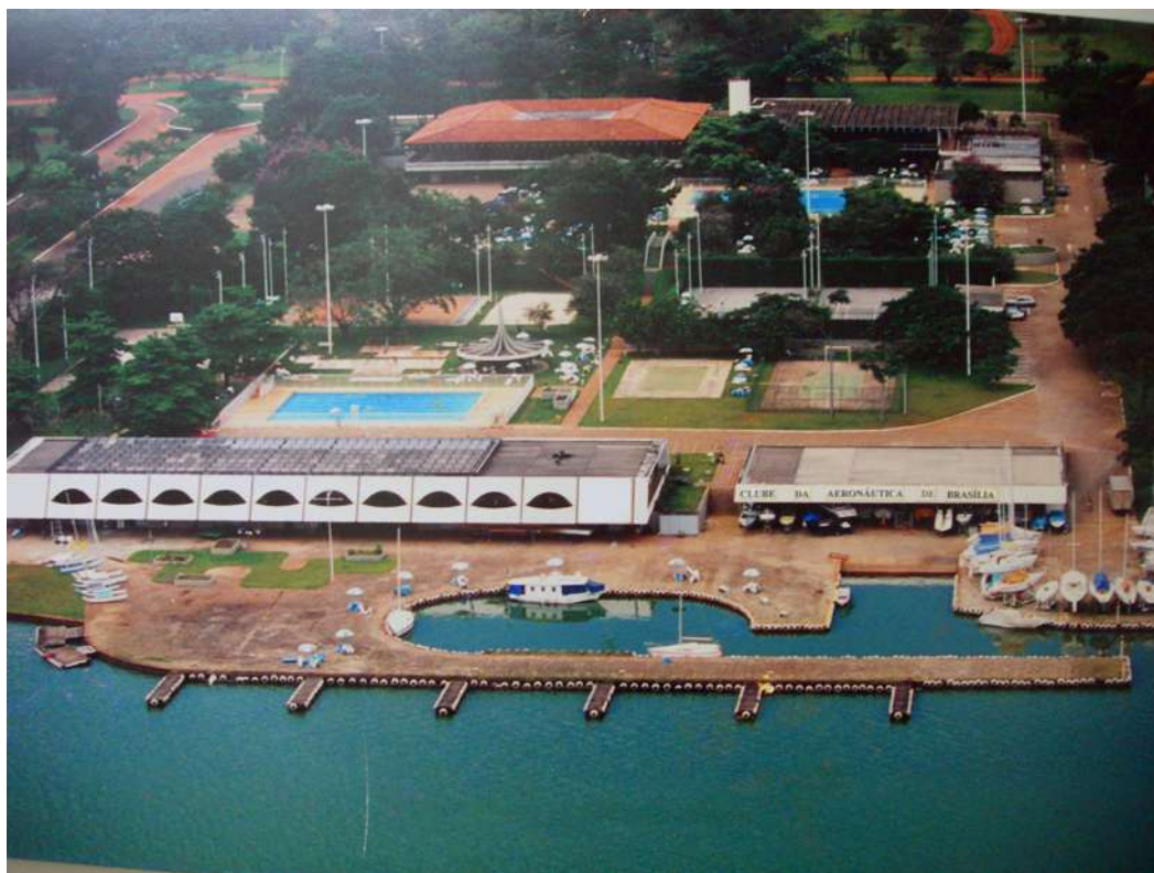
10. Milton Ramos, Clube da Aeronáutica de Brasília (1975). Em primeiro plano, o bloco da náutica. Ao fundo, edifício administrativo e sede social.
