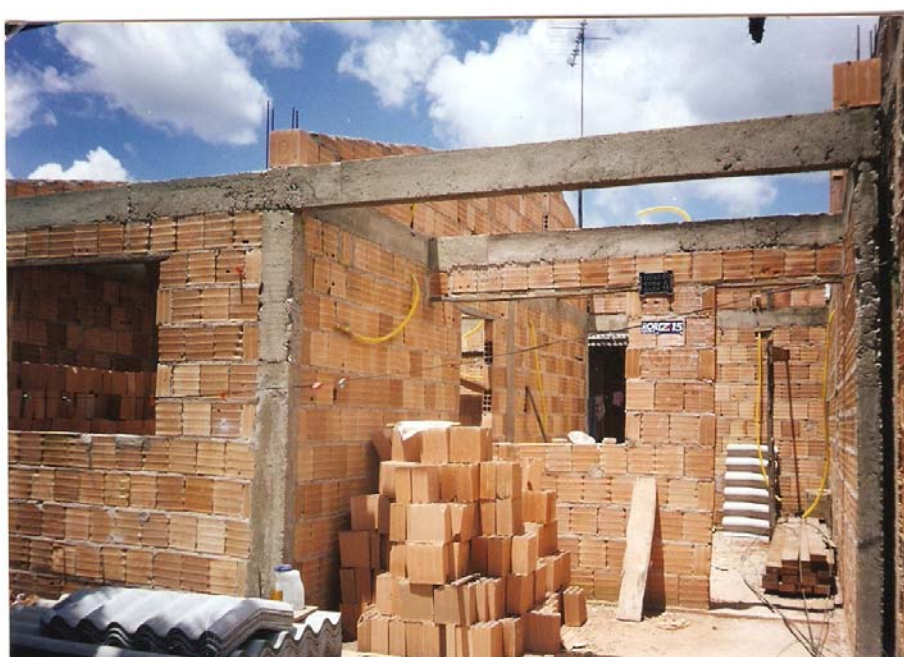
Figura 5.11 – Casa em construção 2. Fonte: (GONZALES, S.F.N.; JUCÁ FILHO, A. SOUZA E SILVA, M.F.; BUSON, M.A., 1998)
