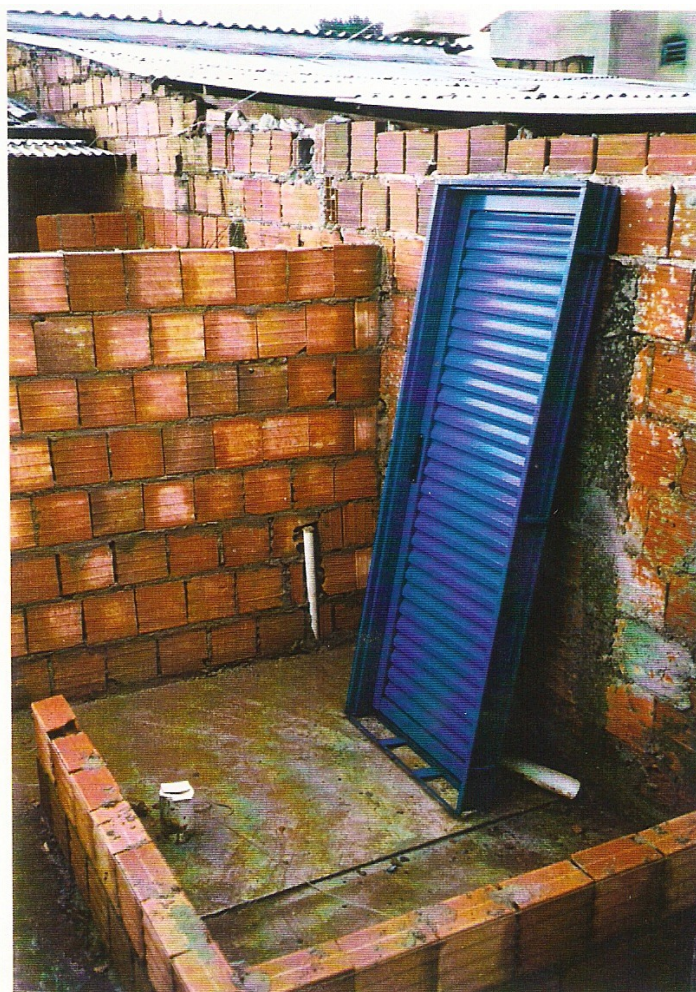
Figura 5.9 – Armazenagem de porta metálica. Fonte: (GONZALES, S.F.N.; JUCÁ FILHO, A. SOUZA E SILVA, M.F.; BUSON, M.A., 1998)
