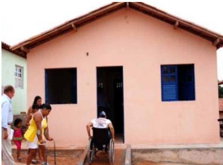
Figura 5.16 – Casa pronta (Moradores entrando). Foto tirada na obra em 1998.
