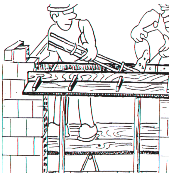
Figura 5.4 – Execução de vergas sobre as janelas. Fonte: SPOSTO (1998)
