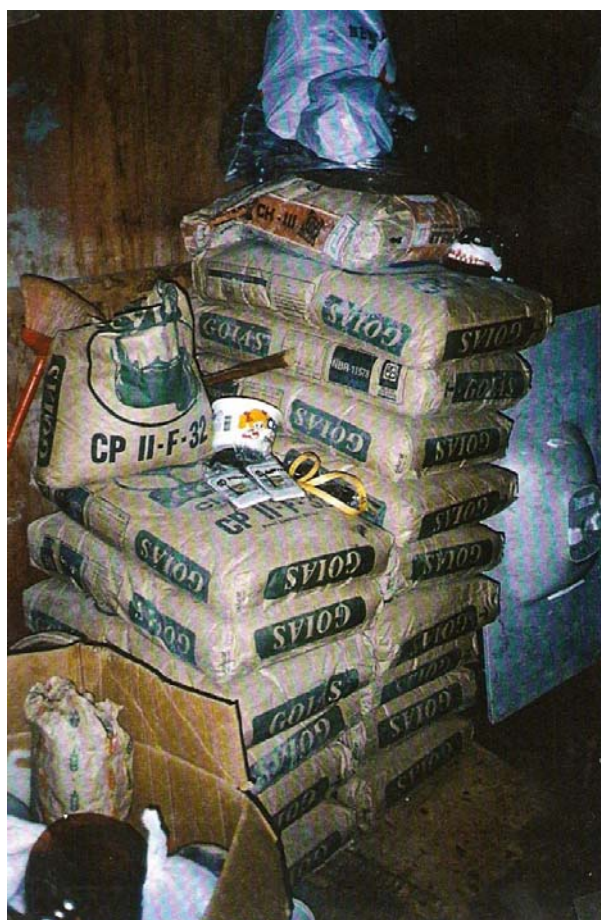
Figura 5.8 – Armazenagem de cimento e aparelhos. Fonte: (GONZALES, S.F.N.; JUCÁ FILHO, A. SOUZA E SILVA, M.F.; BUSON, M.A., 1998)
