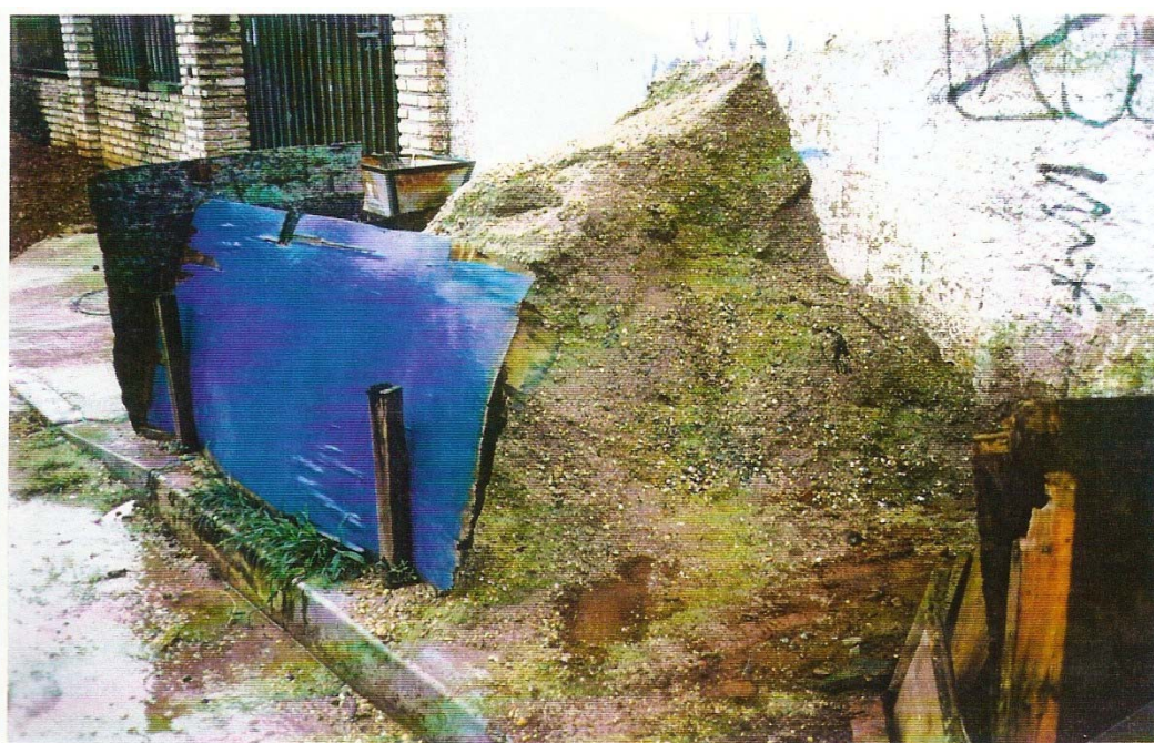
Figura 5.6 – Material armazenado na via pública: areia e brita. Fonte: (GONZALES, S.F.N.; JUCÁ FILHO, A. SOUZA E SILVA, M.F.; BUSON, M.A., 1998)
