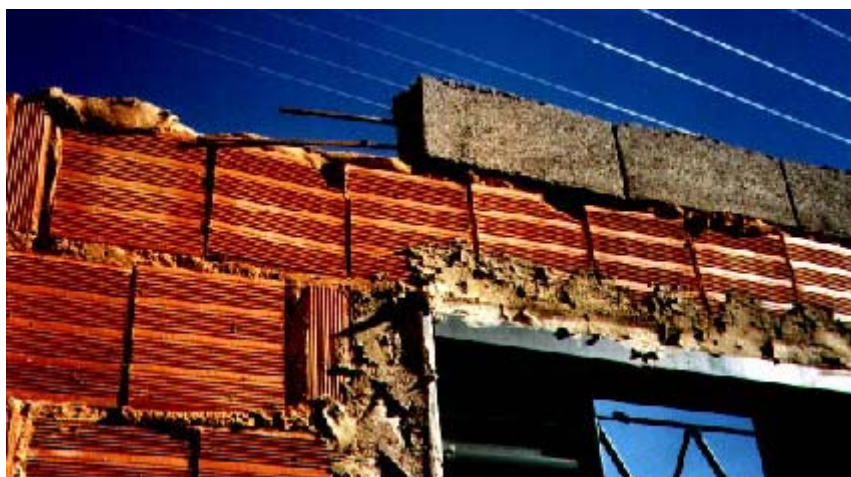
Figura 5.1 – Desperdício de materiais, falta de especificação e de assistência técnica. Fonte: SPOSTO (1999)
