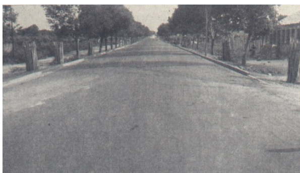
Figura 19 – Avenida Santos Dumont– Caminho para o Aeroporto.
