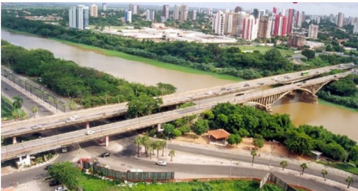
Figura 32: Ponte Juscelino Kubitschek e vista da zona Leste da cidade de Teresina. Fonte: Fontinelis, 2007. Disponível em www.panoramio.com . Acesso em 20/06/2007
