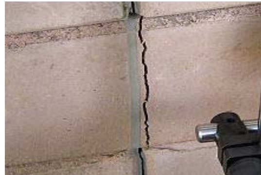
(b) trinca de face tipo 2
