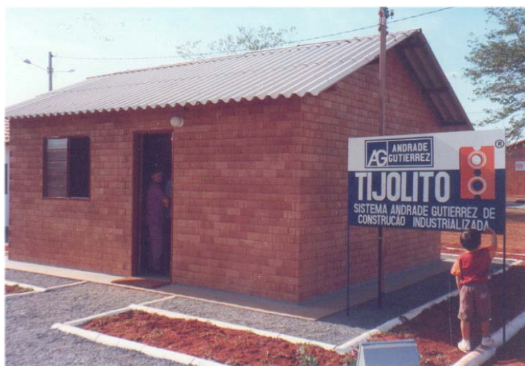
FIGURA 32 – Casa construída em Brasília – Distrito Federal - 1992
