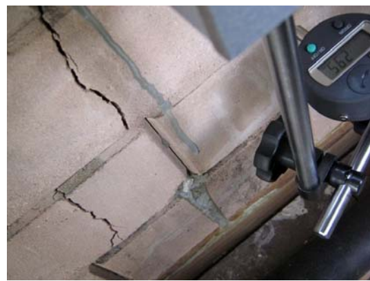
(f) trinca fora das linhas de carregamento
