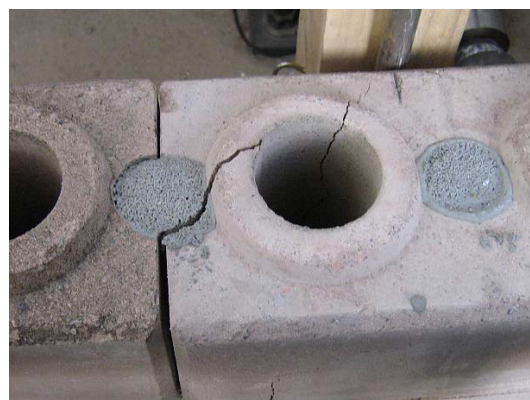
(d) junta rompida fora da flexão pura mp 44i
