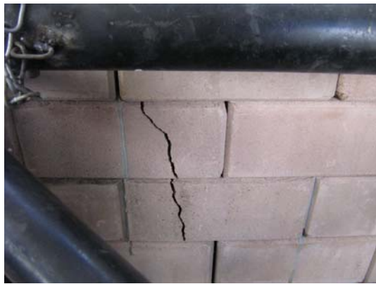
(c) trinca de face 3
