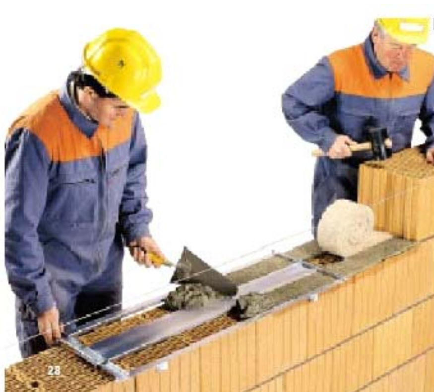
FIGURA 18 – Colocação da argamassa e isolante térmico em blocos não retificados. Fonte: “Catalogo 2003 Wienerberger, France” citado por CAVALHEIRO (2004)
