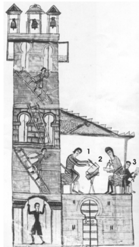
Figura 19. Instrumentos de desenho na sala de riscos da obra. 1-pontas de riscar 2-compasso 3- provável recorte do gabarito. Extraído de Borges Filho, 2005 p. 225, original de Gimpel, Jean. Op.cit., 1973, p. 71.
