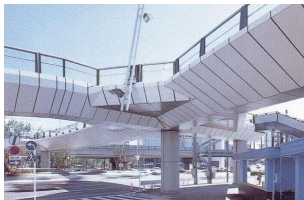
Figura 3.13: fôrmas permanentes de GRC (GRCA, 1995)
