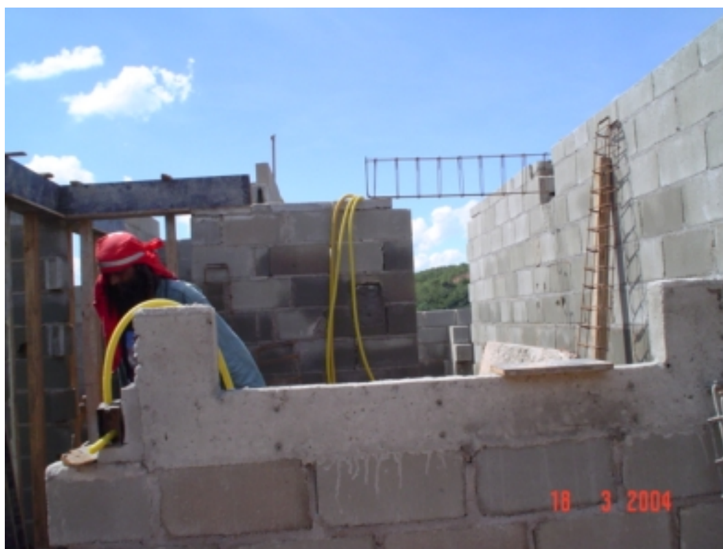
FIGURA 5.12 – Execução da contraverga (Foto: Whesley Uelder Pereira, 2004).
