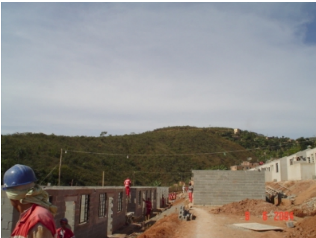
FIGURA 5.8 – Utilização de tijolos maciços nas vergas (Foto: Whesley Uelder Pereira, 2004).
