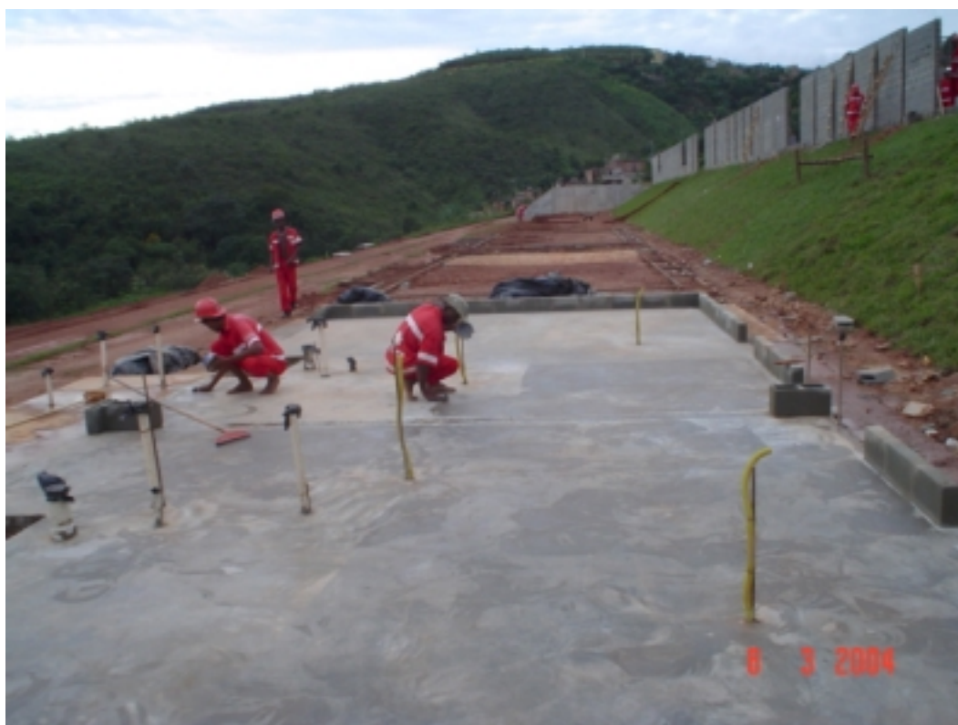
FIGURA 5.14 – Polimento do radier (Foto: Whesley Uelder Pereira, 2004).
