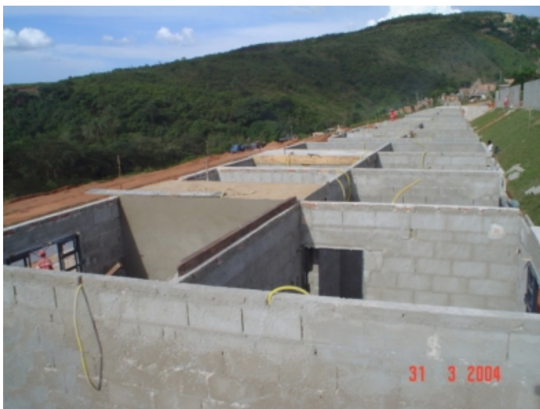
FIGURA 5.10 – Execução das alvenarias, ajuste dimensional da altura (Foto: Whesley Uelder Pereira, 2004).
