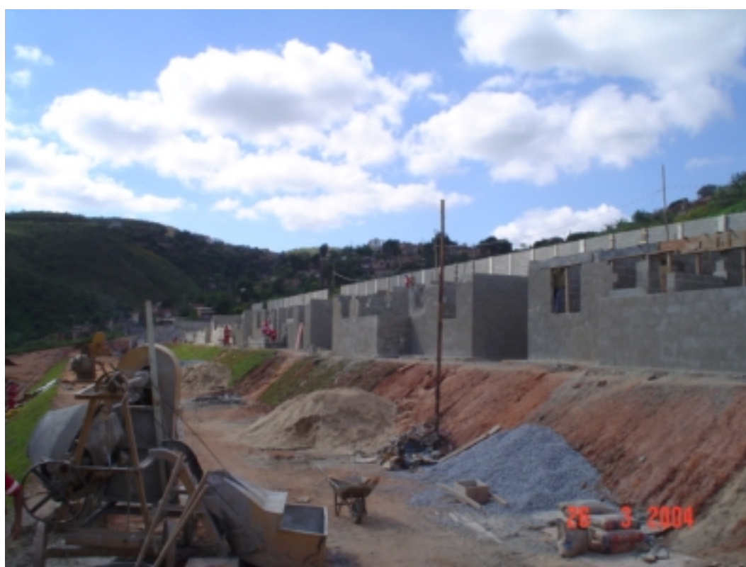
FIGURA 5.7 – Execução das vergas (Foto: Whesley Uelder Pereira, 2004).
