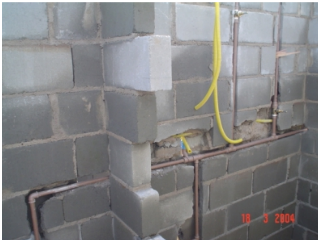
FIGURA 5.1 – Embutimento das instalações hidráulicas (Foto: Whesley U. Pereira, 2004).
