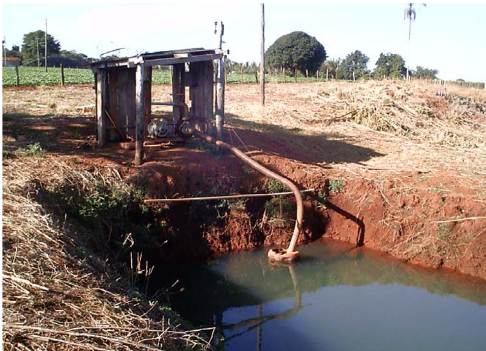
Figura 3. Aspecto da captação de água do Rio do Peixe para irrigação de pequenas culturas por aspersão convencional, no município de Caturai.
