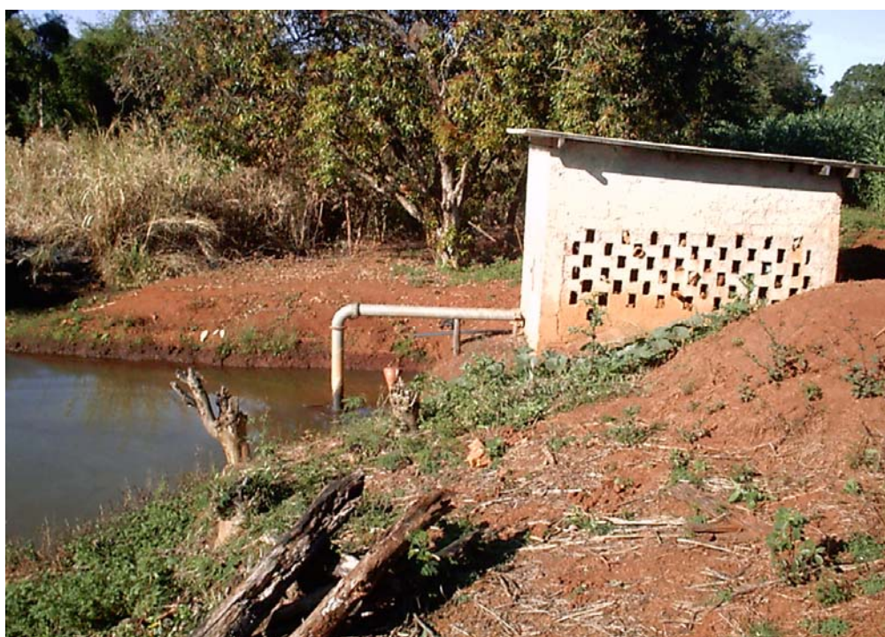
Figura 4. Aspecto da captação de água do Rio do Peixe para irrigação por aspersão convencional tipo Pivot Central, no município de Caturai.
