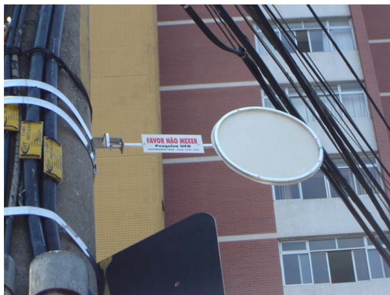
Figura 3. Instalação dos SISCO nos postes de energia elétrica.
