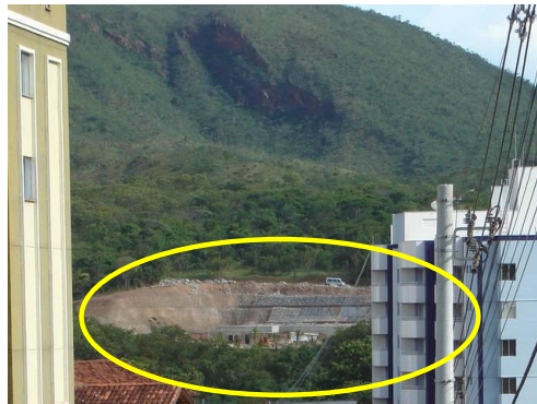
Figura 31 – Construção da piscina de ondas na Pousada do Rio Quente.
