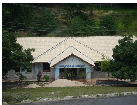
Figura 11 – Balneário municipal construído em 1950 em reforma (imagem atual).
