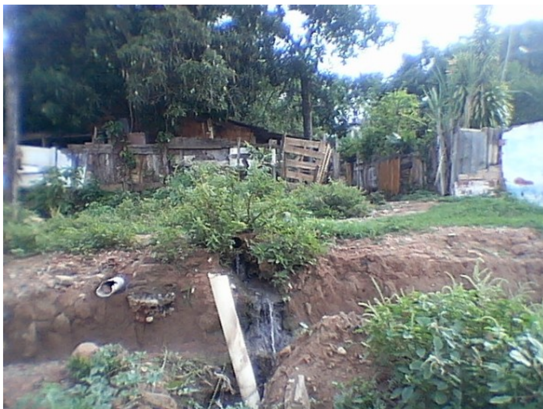
Ilustração 3 - Esgoto correndo a céu aberto em Goiânia - Invasão Emílio Povia, 2005.
