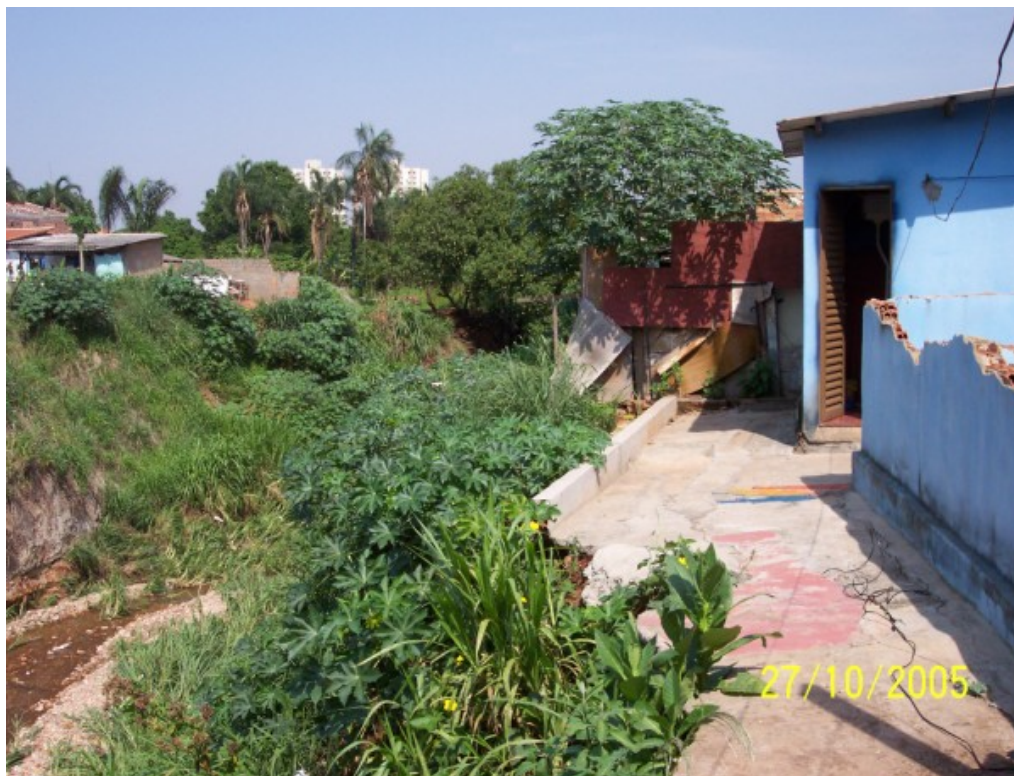
Ilustração 7 – Construção em área non edificandi às margens do Córrego Cascavel.
