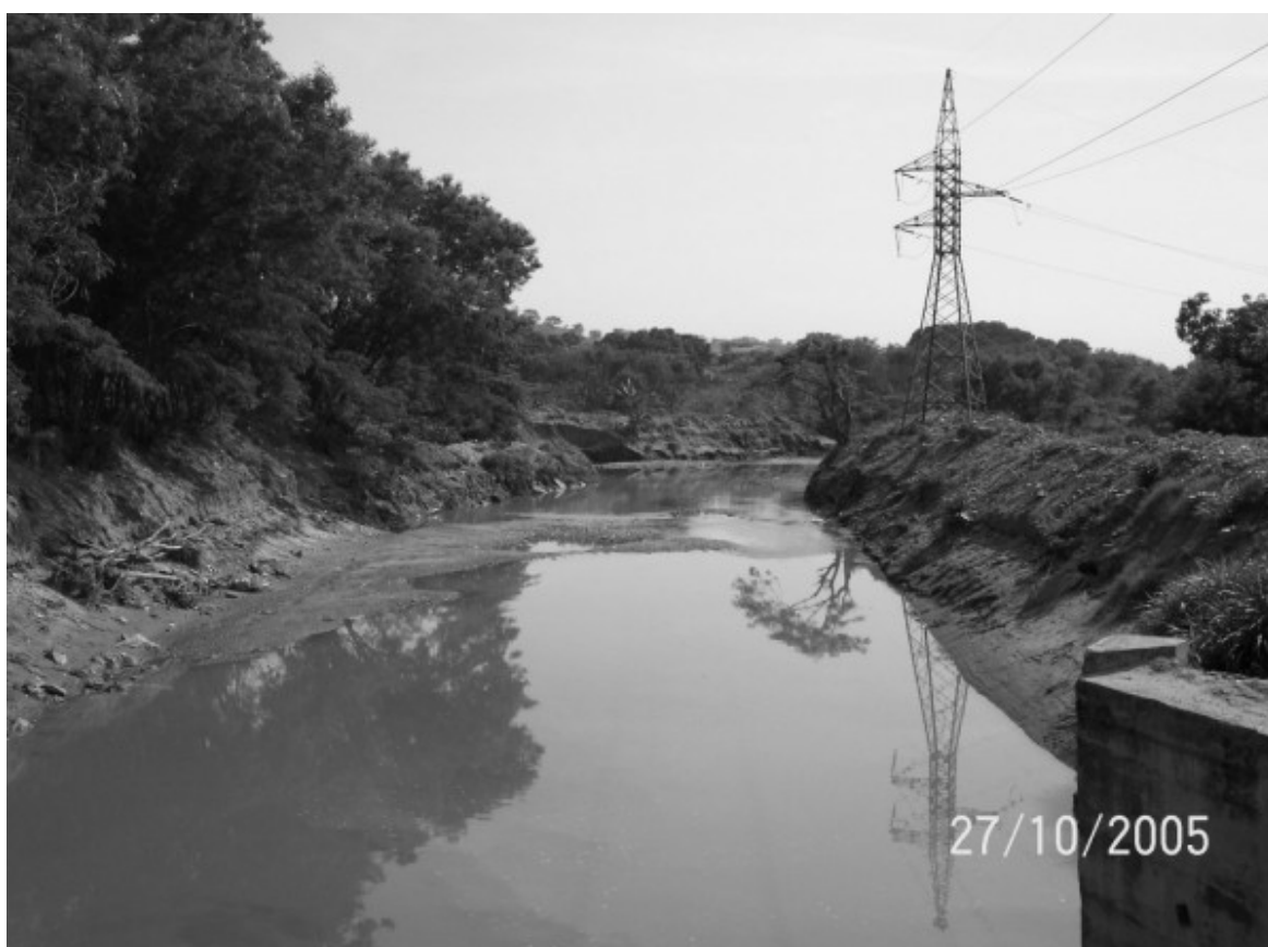
Ilustração 4 - Dique construído para evitar enchentes, córrego Anicuns, foto do autor.
