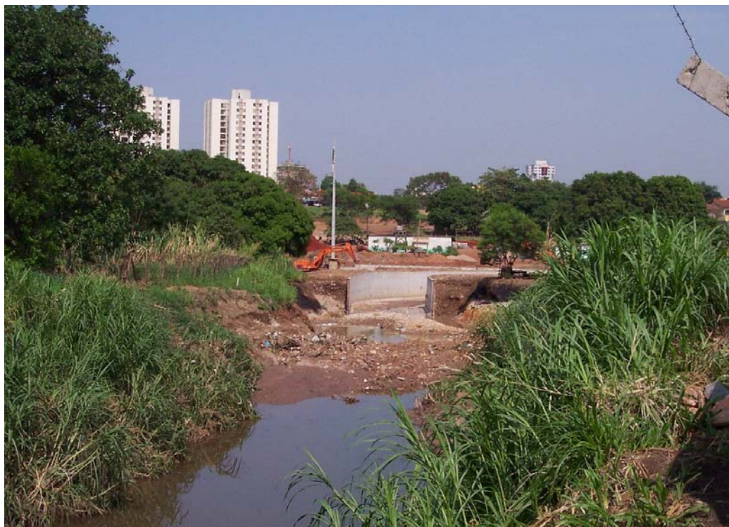
Ilustração 9 - Obras de Canalização do Córrego Cascavel, 2005.
