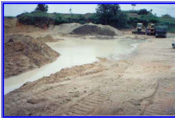
Foto 7. BR 367/BA – Subtrecho: Eunápolis-Porto Seguro. Empoçamento devido à inexistência de drenagem em caixa de empréstimo.
