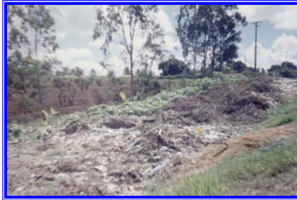
Foto 11. BR 101/BA – Subtrecho: Esplanada-Entre Rios. Exemplo de aterro sanitário (lixão) em local impróprio, na faixa de domínio.
