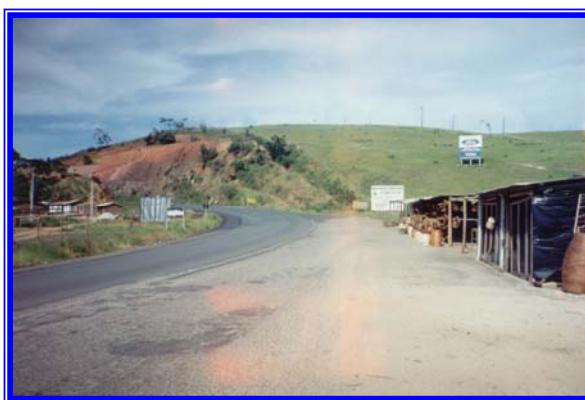
Foto 10. BR 101/BA – Subtrecho: Governador Mangabeira-Gandu. Exemplo de ocupação desordenada da faixa de domínio.
