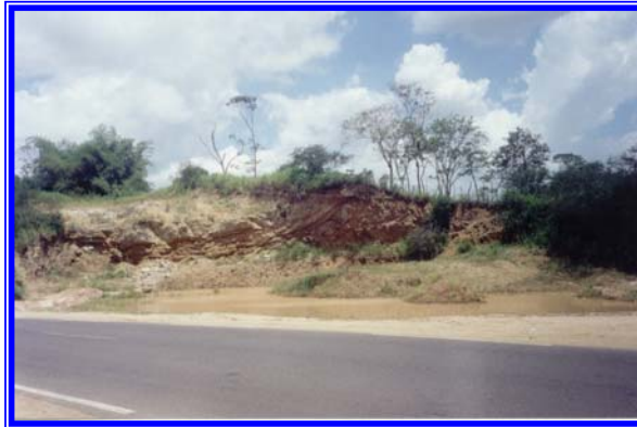
Foto 6. BR 101/BA – Subtrecho: Governador Mangabeira-Gandu. Empoçamento devido à falta de drenagem em uma caixa de empréstimo.
