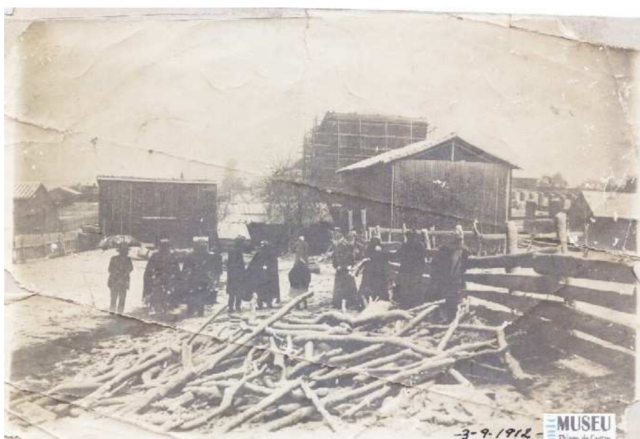
FIGURA 1 – INÍCIO DAS OBRAS PARA A CONSTRUÇÃO DO GRUPO ESCOLAR EM LAGES, 03 DE SETEMBRO DE 1912
