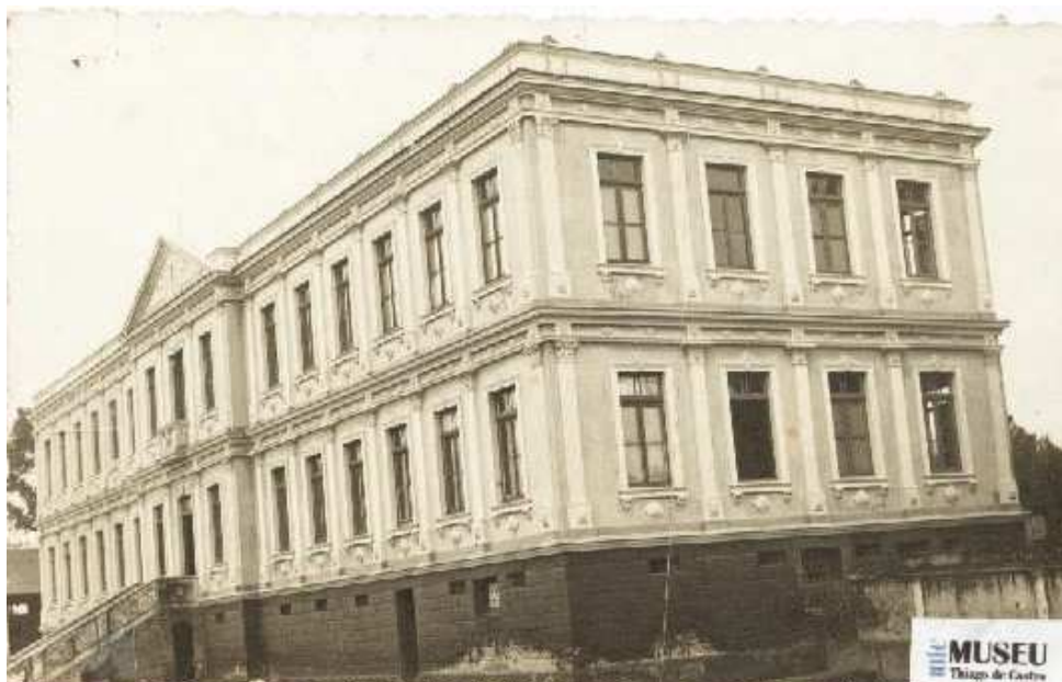
FIGURA 5 - MOSTRA O GRUPO ESCOLAR EM FASE FINAL DE CONSTRUÇÃO.
