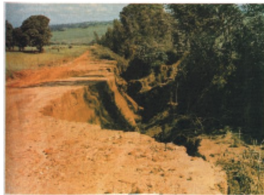
Foto: 4, 5 e 6. A esquerda: Sistema de terraços mal dimensionados; à direita voçorocas nas estradas; em baixo: voçoroca de divisas de propriedades.
