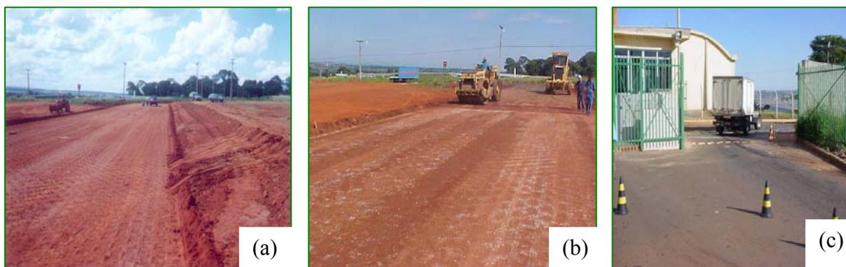
**Figura 3.12** Evolução na execução do pavimento em Goiânia: (a) subleito preparado; (b) base preparada; (c) via pavimentada (SILVA, 2004)
