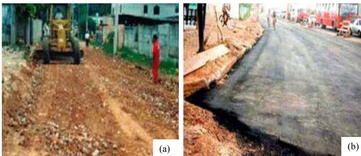
**Figura 3.5** Utilização de agregados reciclados em pavimentação na cidade de Belo Horizonte: (a) Na execução; (b) Com revestimento (PREFEITURA DE BELO HORIZONTE, 2006)
