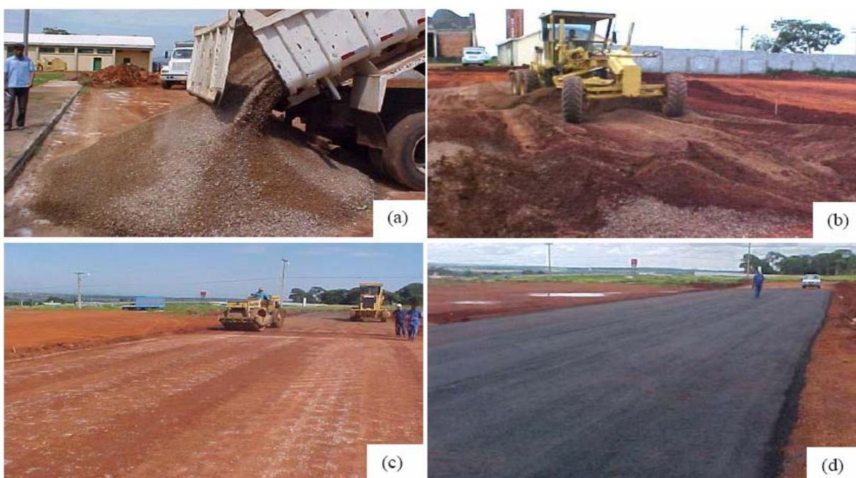
**Figura 4.20** Execução da pista do CEASA: (a) deposição do material misturado na pista; (b) espalhamento; (c) compactação; (d) execução do revestimento (ASSIS et al., 2005)
