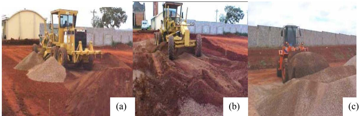
**Figura 3.11** Homogeneização da mistura no campo: (a) 1º Processo; (b) 2º Processo; (c) 3º Processo (SILVA et al., 2006)
