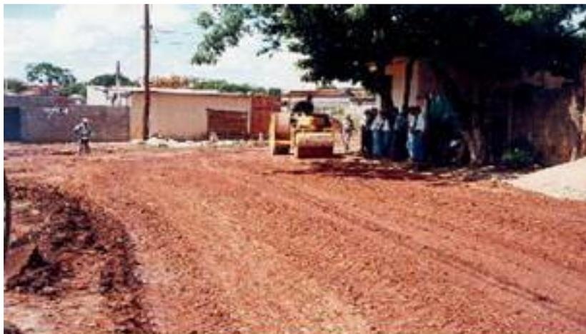
**Figura 3.6** Pavimentação com agregado reciclado em Ribeirão Preto (PINTO, 1999)
