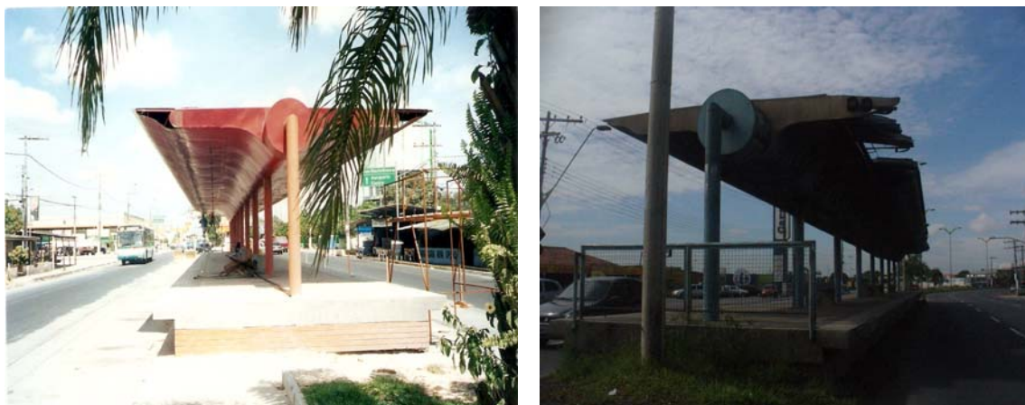
(a) em construção; (b) dezembro de 2008. Fotos do autor.
