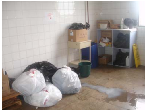
Figura 33 - Vazamento proveniente dos sacos de RSS
