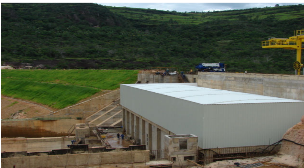
Foto 23 – Vista Lateral da Barragem PCH
