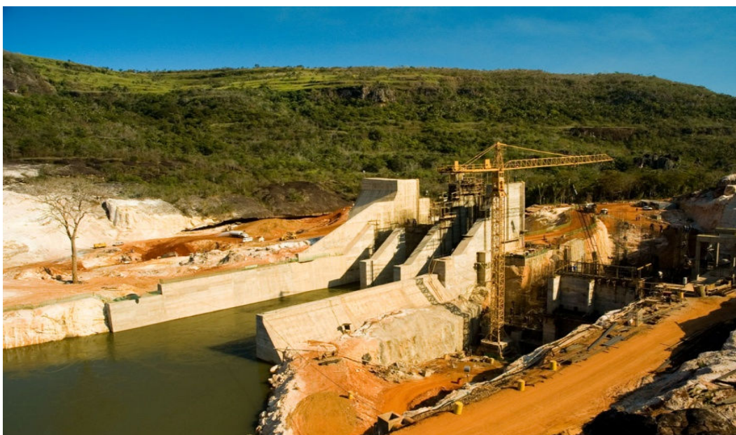
Foto 22 – Construção da Barragem PCH
