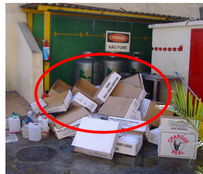
Foto 2. Excesso de caixa de papelão na área de acesso ao RPP.
