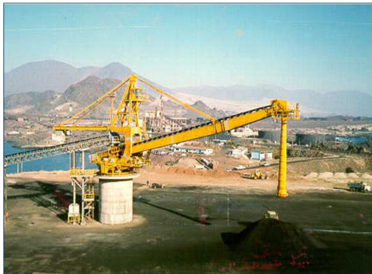
Figura 5.4 – Transportador de minério
