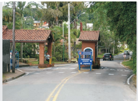
Fig. 4.12 Portaria do Condomínio São Joaquim Vinhedo/SP
