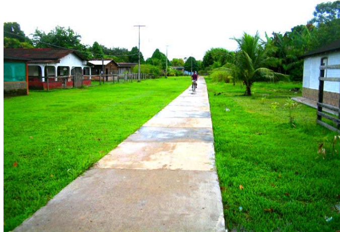
FIGURA 5: São Carlos, passarelas construídas na atual gestão municipal. Foto: Maria José, abril de 2006.
