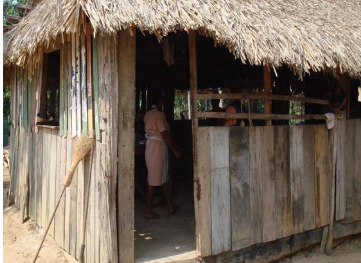
FIGURA 7: Foto de residência, construída de madeira da floresta e coberta de palha. Foto: Elaine, abril 2006
