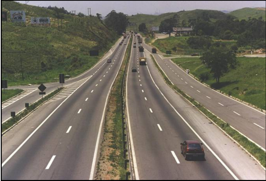
Figura 04 - Exemplo de sinalização horizontal – cor branca Fonte: (3)
