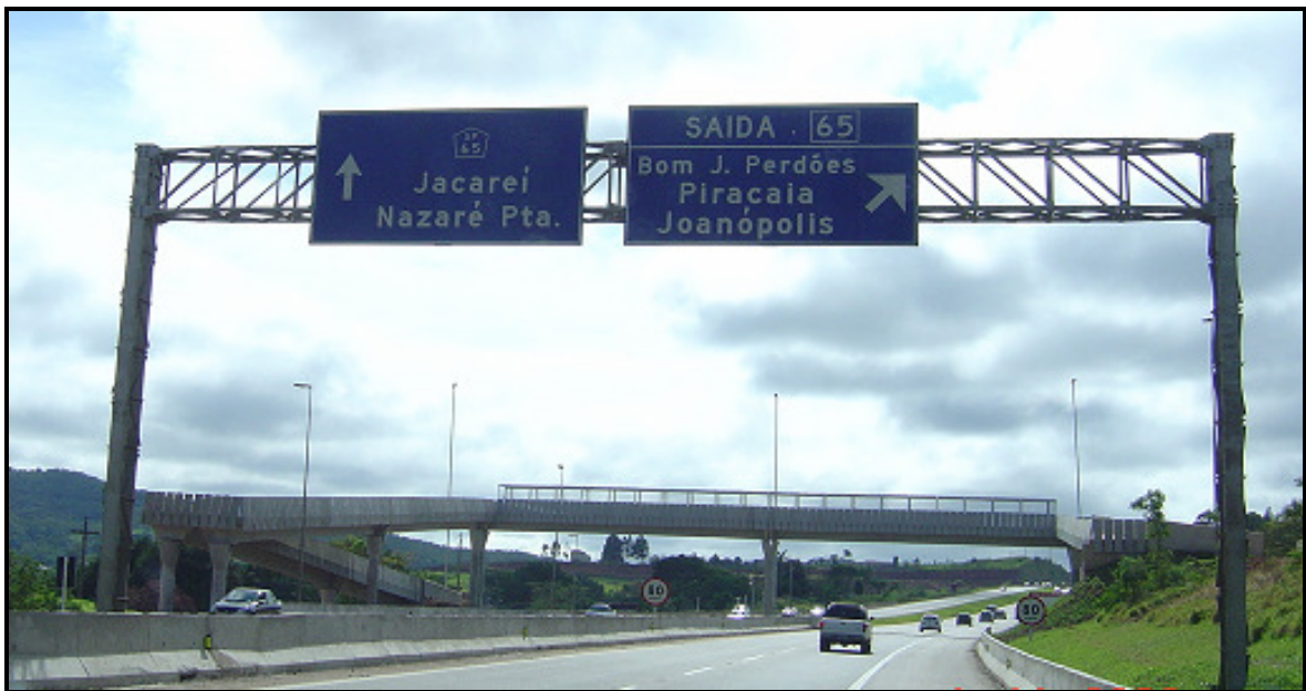
Figura 02 - Exemplo de sinalização vertical – suspensa sobre a via
