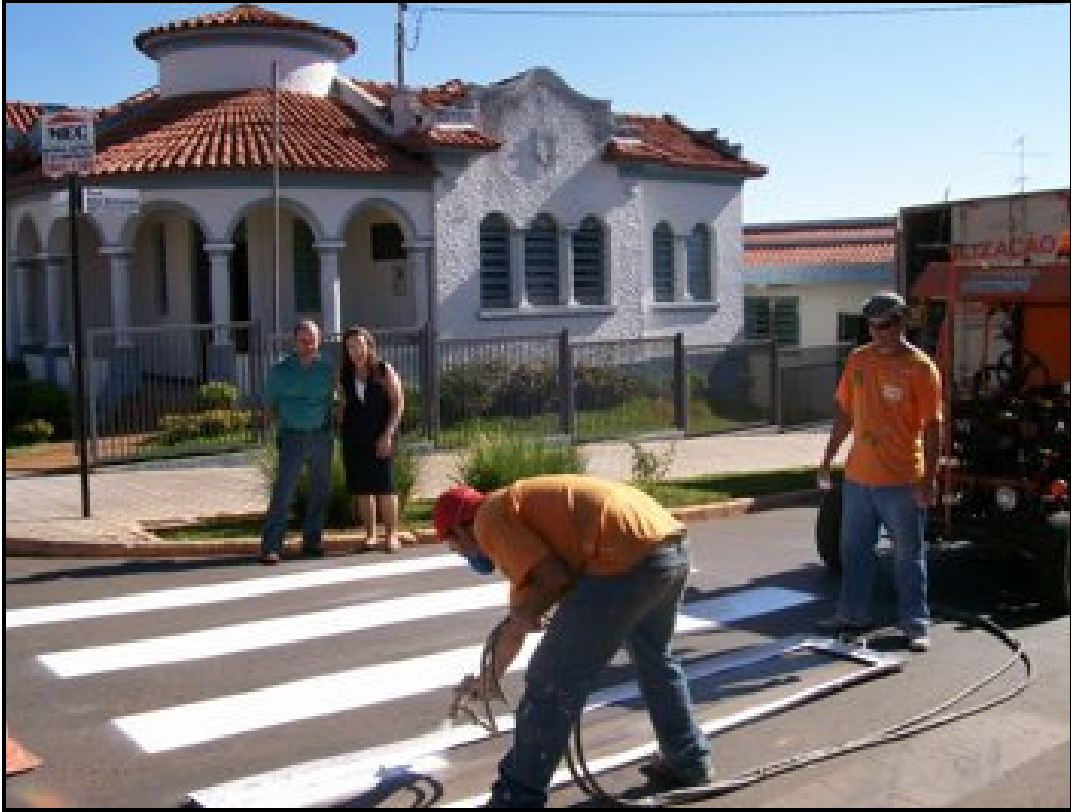
Figura 10 - Pintura manual com pistola Fonte: (11)
