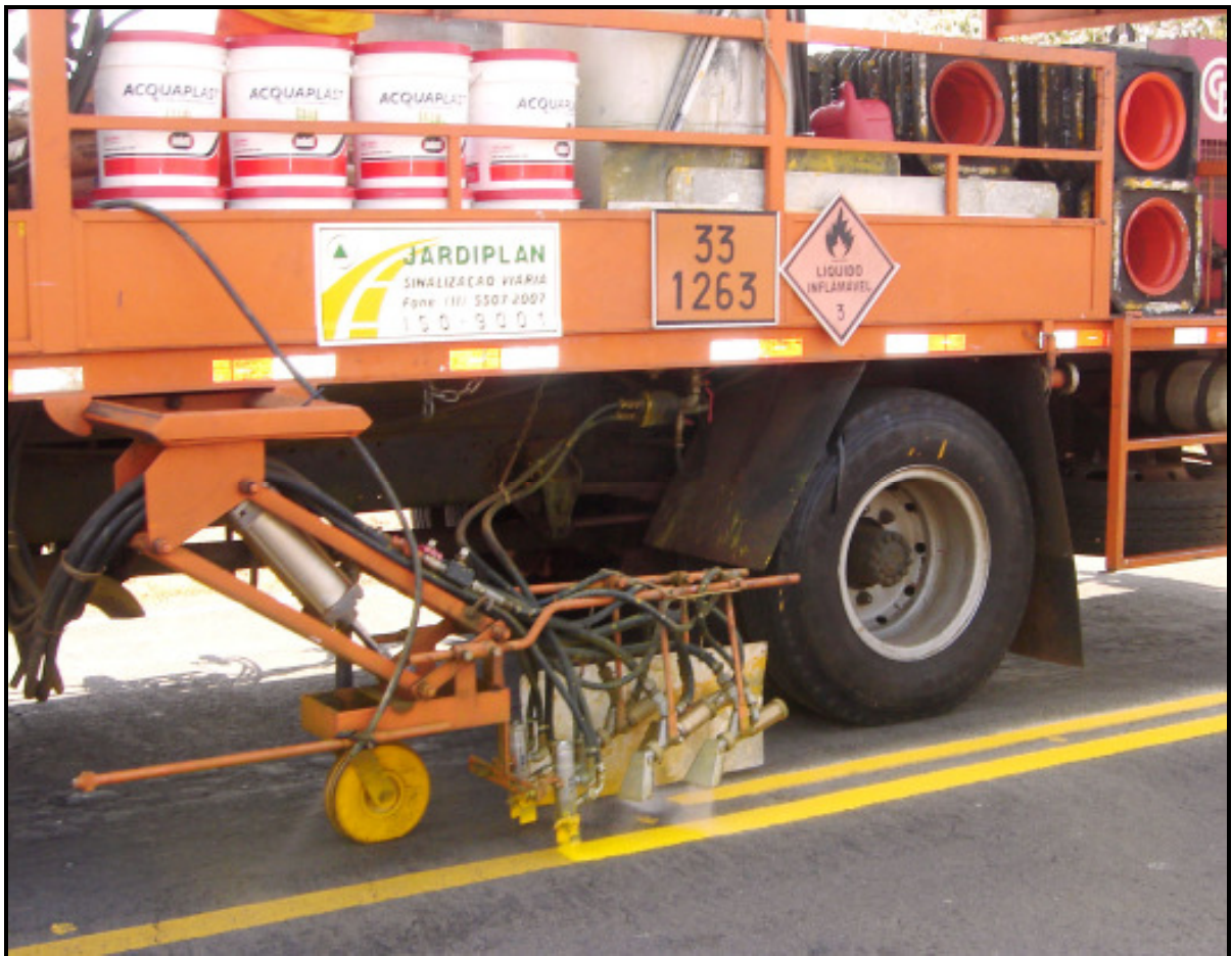
Figura 09 - Aplicação de tinta com equipamento apropriado Fonte: (3)
