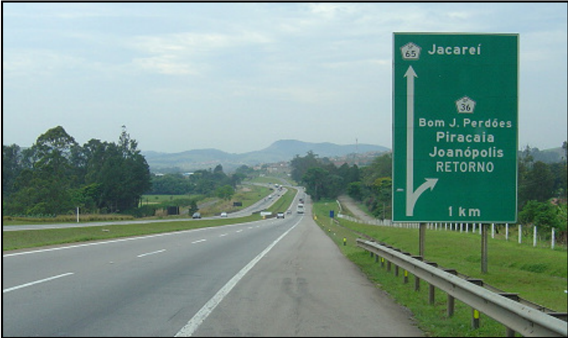
Figura 03 - Exemplo de sinalização vertical – à margem da via
