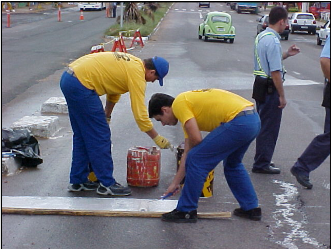
Figura 11 - Pintura manual com rolo e trincha (faixa de pedestres) Fonte: (12)
