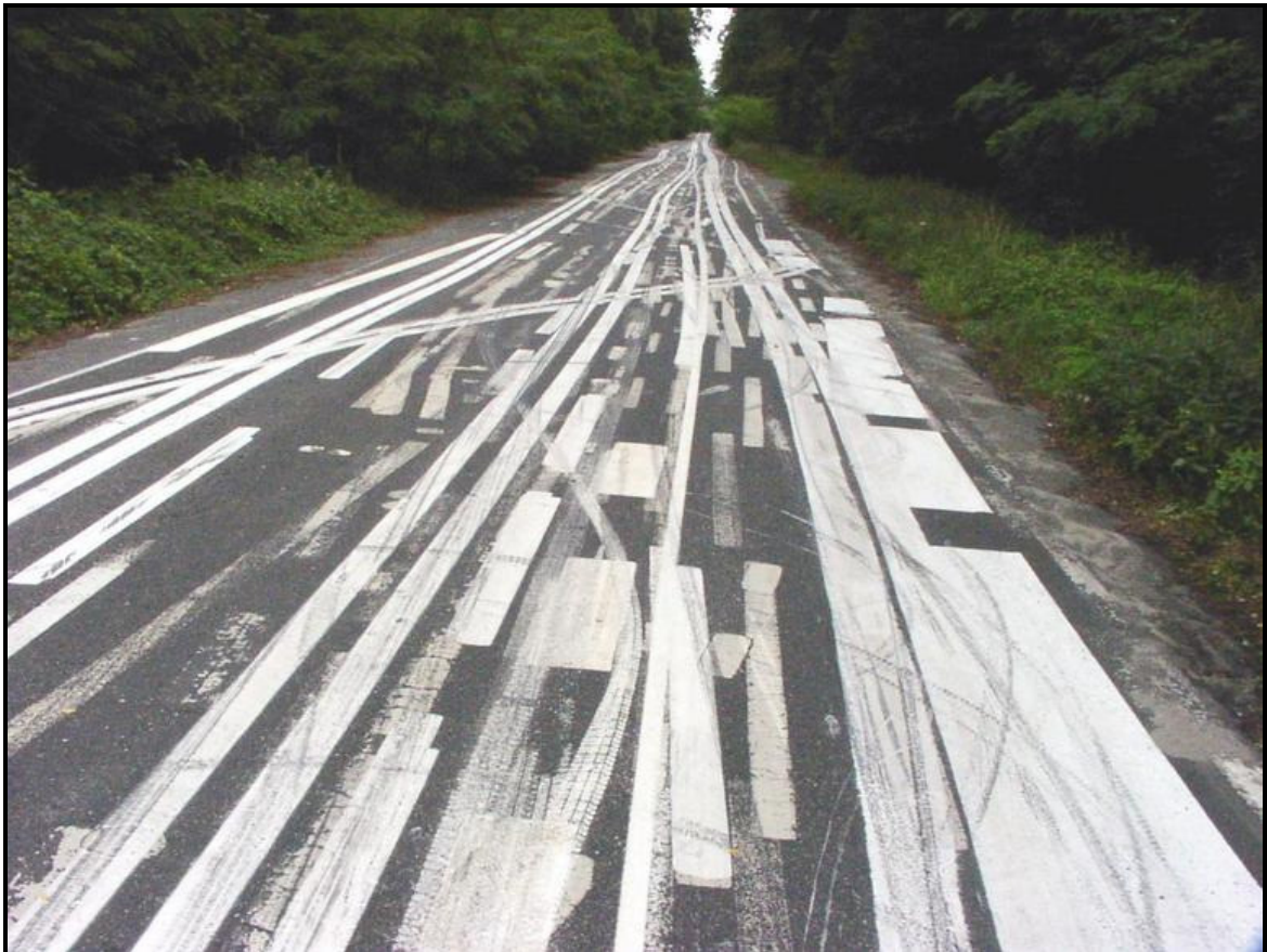
Figura 01 - Liberação da via antes da secagem da sinalização horizontal. Fonte: (3)
