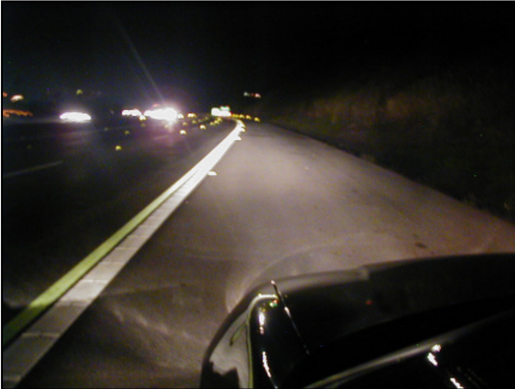
Figura 07 - Sinalização horizontal com elementos de refletorização Fonte: (3)
