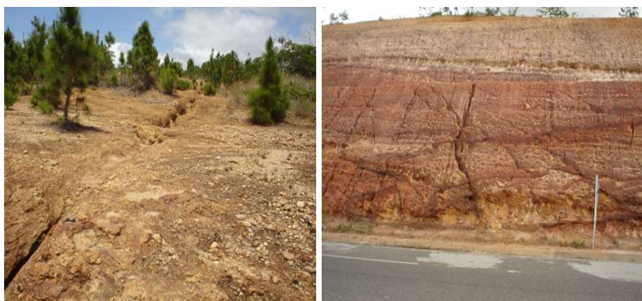
Figura 5.11. À esquerda, superfície em rampa encontrada no bloco do Barreiras supostamente rebaixado tectonicamente, formando um patamar. A foto mostra o afloramento de laterita por erosão laminar em área de Argissolos e Neossolos Litólicos. Observe-se a fratura possivelmente relacionada ao abatimento tectônico desse bloco sedimentar. Na foto à direita, o corte de estrada mostra fraturas no mesmo bloco do Barreiras.
