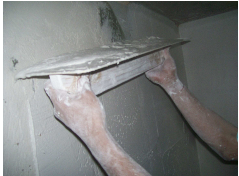
Figura 2.12– Fotos da argamassa de gesso e sua aplicação sobre alvenaria em construções de unidades habitacionais do Programa Vila Viva do Aglomerado da Serra executado em Belo Horizonte.
