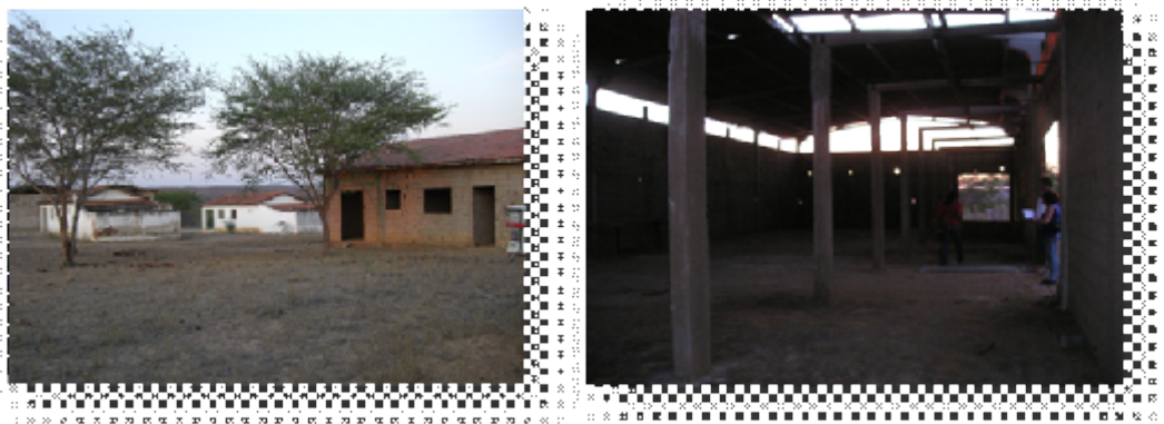
Figura 5.10 - Obras inacabáveis e abandonadas
