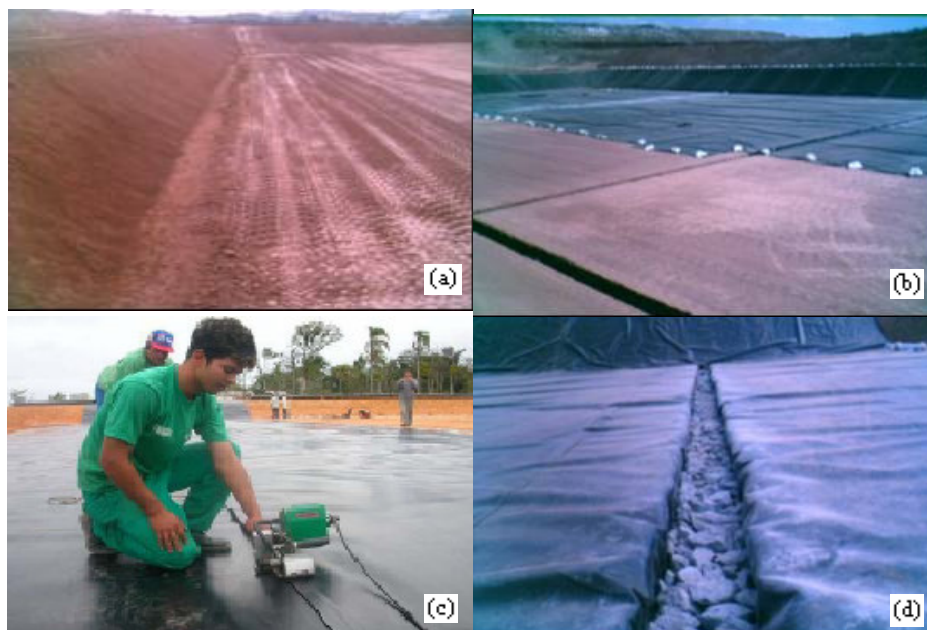
Figura 45: Aterro sanitário em construção. Preparação da área (a); colocação da geomembrana, canal de drenagem (b); execução da solda da geomembrana (c); execução do dreno do percolado sob a geomembrana (d).
