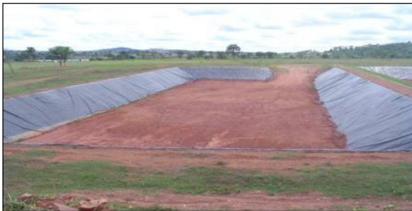
Figura 16: Trincheira construída no aterro sanitário de Trindade para disposição dos resíduos sólidos urbanos
