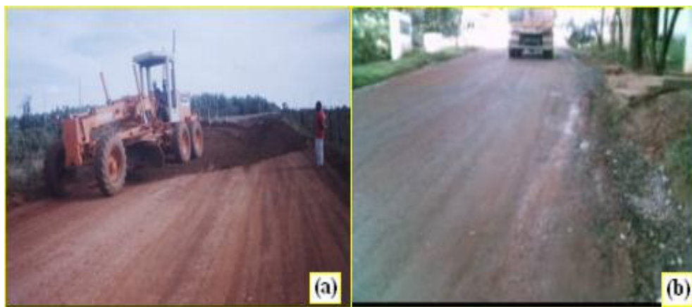
Figura 6: Via de acesso interna na área do aterro sanitário de Anápolis (a) e Goiânia (b)
