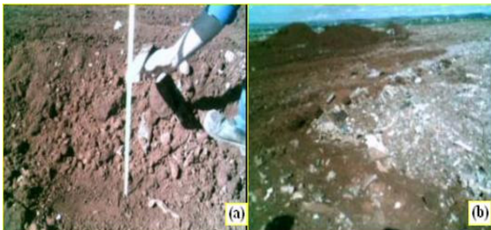
Figura 19: Cobertura final do aterro sanitário de Goiânia. Espessura da camada de solo de jazida (a), cobertura da massa de lixo com entulho (b)
