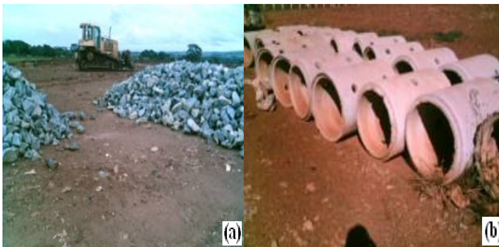
Figura 22: Material de construção mantido em estoque na área do projeto de Anápolis. Estoque de pedra maroadada (a), tubos de concreto (b)
