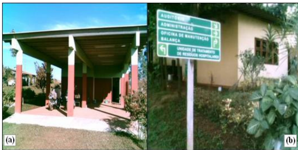
Figura 9: Instalações de apoio do projeto de Aparecida de Goiânia (a) e Goiânia (b).
