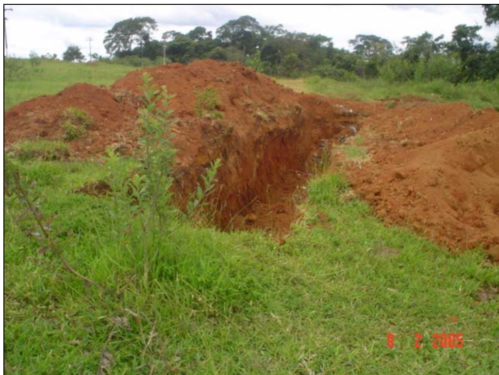
Fotografia 15 Vista das valas próximas ao gradeamento onde é depositado o material gradeado
