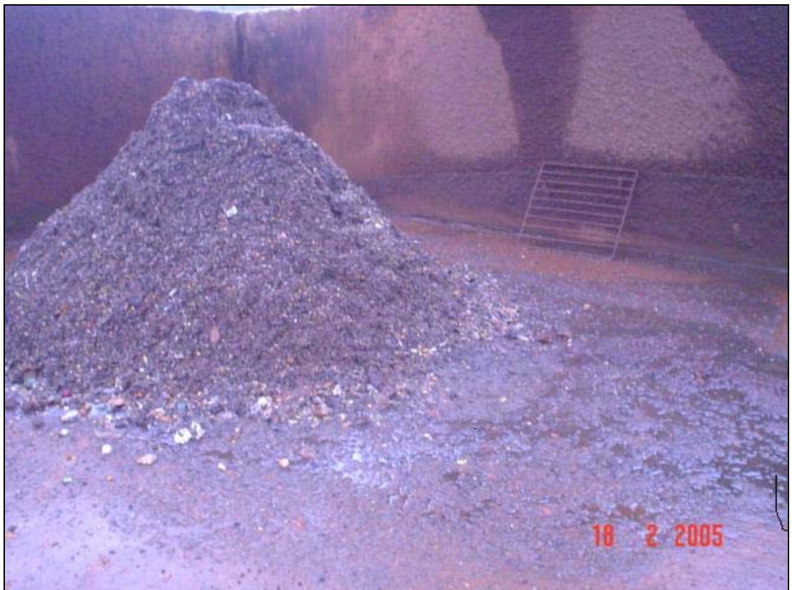
Fotografia 9 Vista do depósito de areia retirada do desarenador
