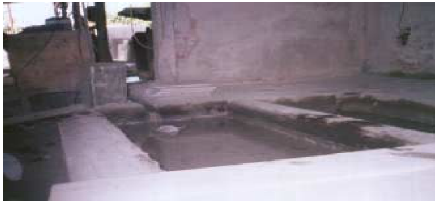
Ilustração 23 - Tanques de decantação da empresa B.
