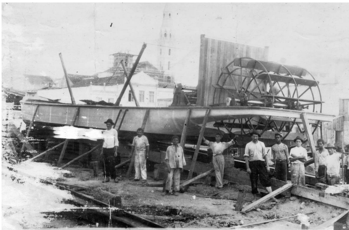
Foto nº4: Estaleiro na rua Sete de Setembro, ao fundo a Igreja Nossa Senhora das Dores com apenas uma das torres construídas, no ano de 1900 (AJAFM)
