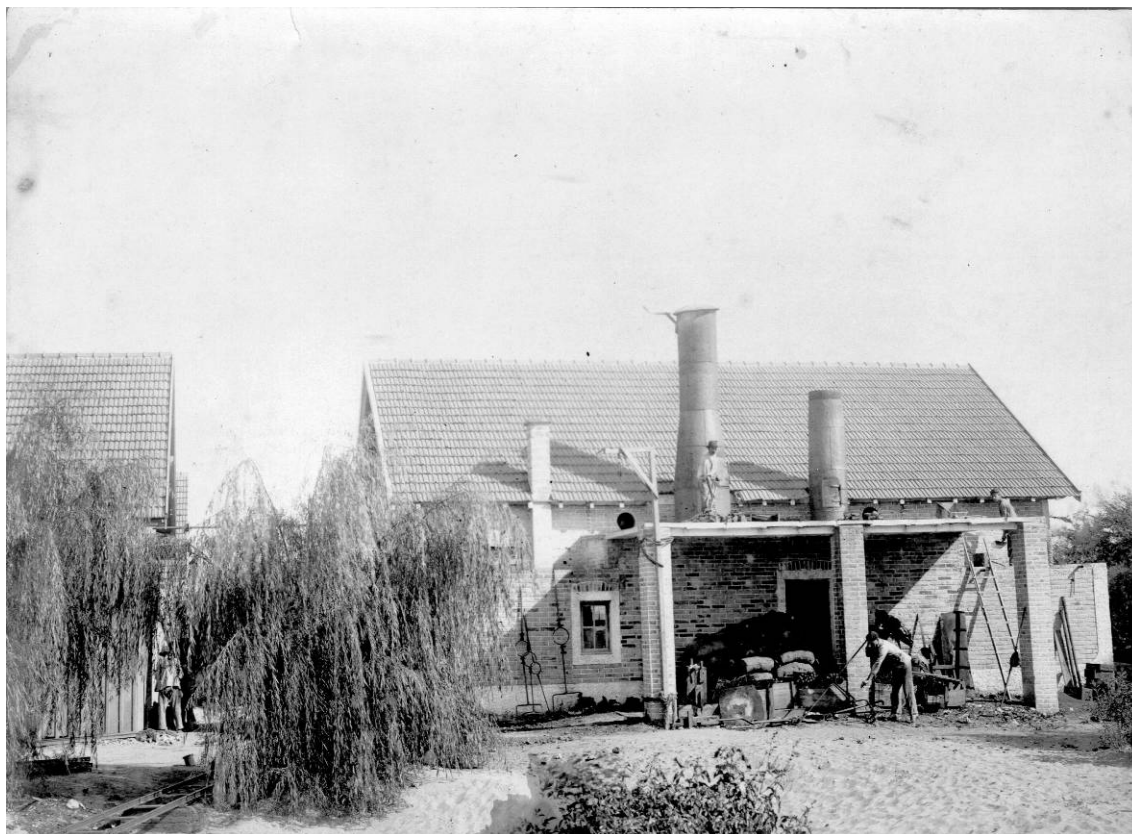
Foto nº25: Prédio da fundição, desabou na enchente de 1936 (AJAFM).
