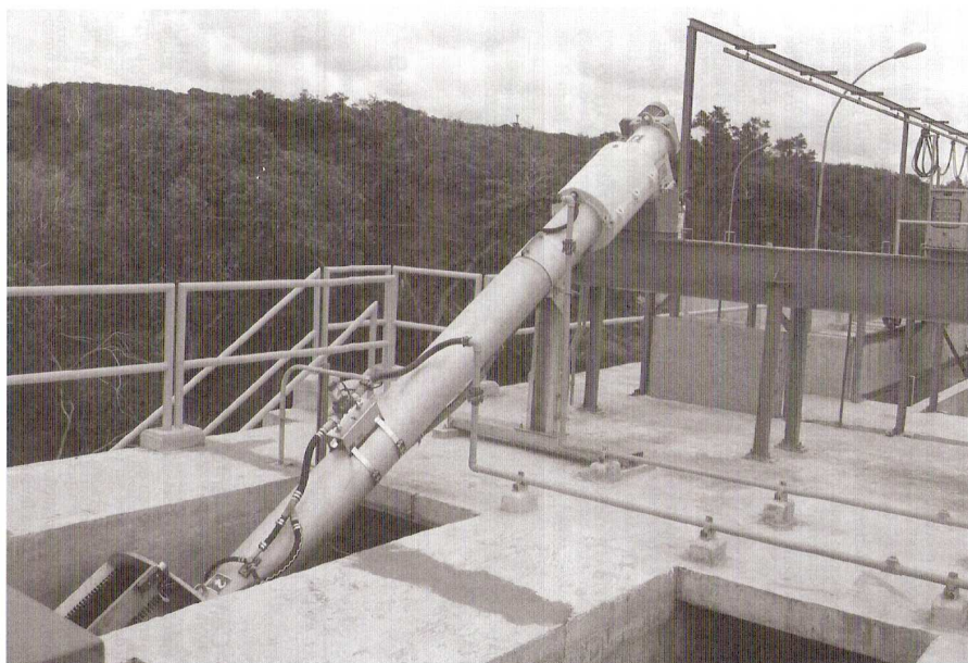
Figura 3 – Grade com parafuso transportador, ETE Búzios, RJ.
