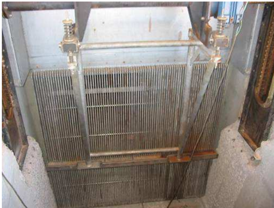
Figura 1 – Grade com acionamento e arraste do rastelo por cremalheira, ETE - Goiânia.
