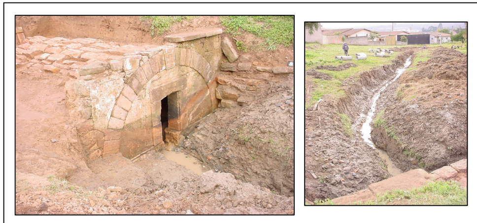
FIGURA 17: Obras iniciais para a construção da praça em 2004. Fonte: Jornal O Malho.
