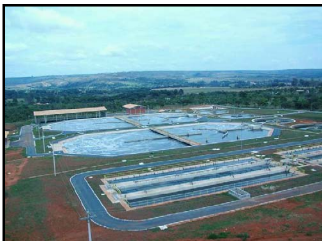
Figura 5.11 – Vista aérea parcial da ETE Gama.
