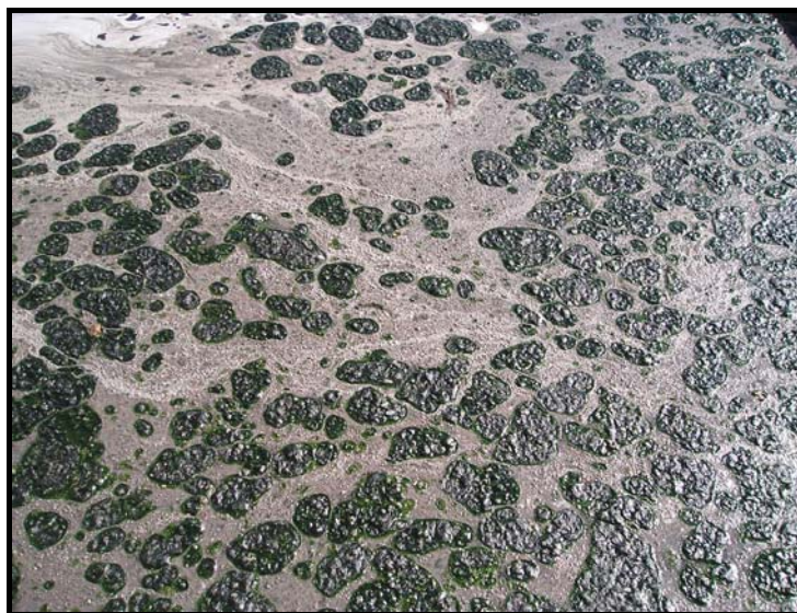
Figura 5.35 – Formação de espuma de coloração esverdeada no reator anaeróbico de fluxo ascendente da estação de tratamento de esgotos do Gama.
