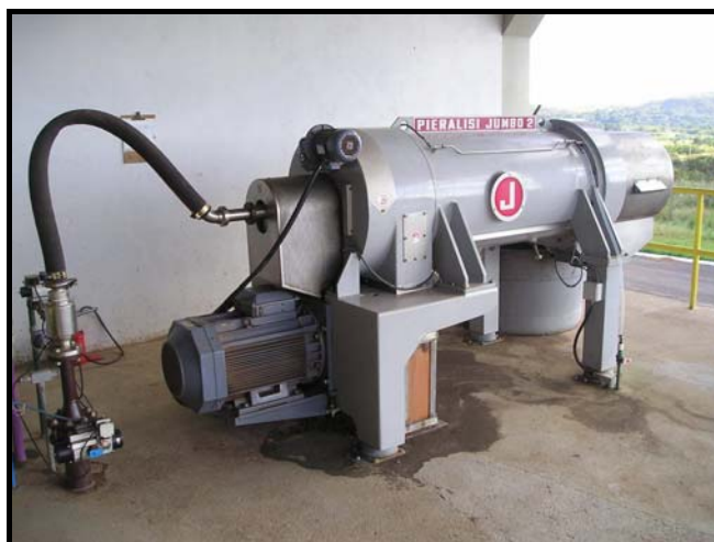
Figura 5.20 – Vista parcial da centrífuga decanter da ETE Gama.
