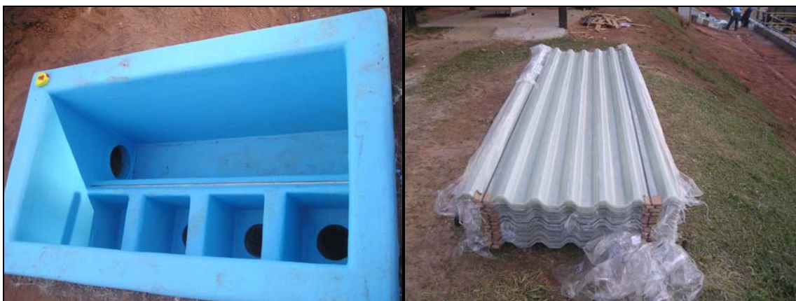
Figura 5.44 – Implantação de alterações de projeto nos reatores UASB da ETE Paranoá. Revestimento das caixas de coleta e separadores de fases em fibra de vidro.
