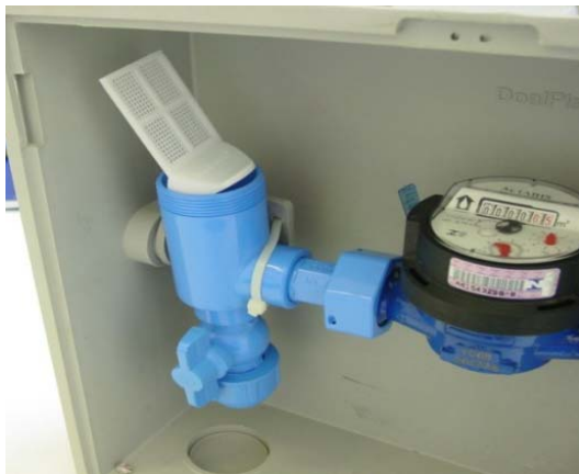
Figura 3.22 – (a) Filtro de retenção para prevenção de obstrução no hidrômetro; (b) Obstrução provocada por areia no filtro de um medidor do tipo volumétrico
