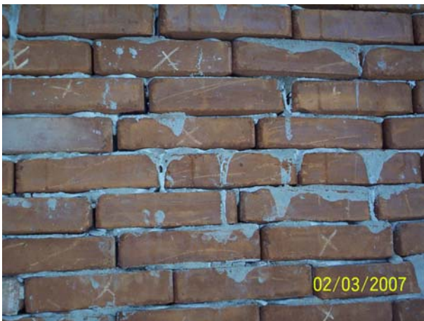
Figura 3.21 Confeção das paredes.
