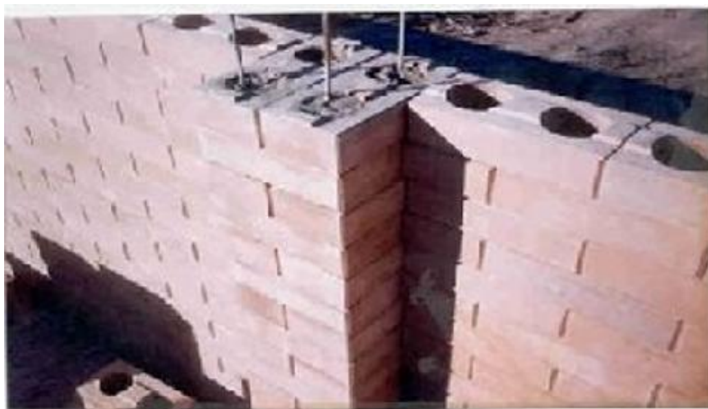
Figura 2. Concretagem dos pilares.
