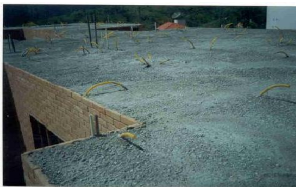
Figura 6. Concretagem da laje.
