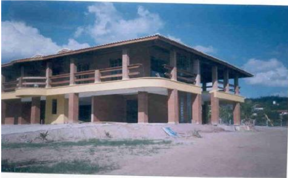
Figura 8. Vista da edificação.
