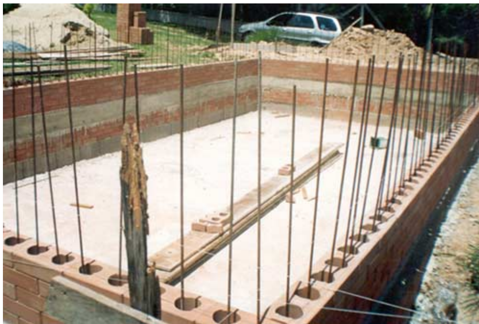
Figura 9. Estrutura de contenção de uma piscina.
