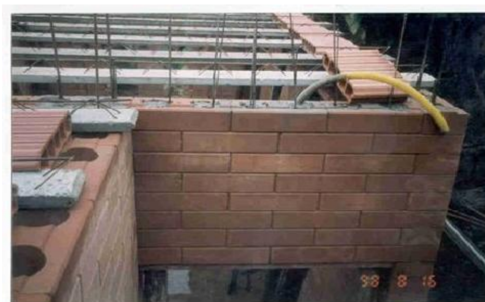
Figura 4. Colocação das treliças da laje.
