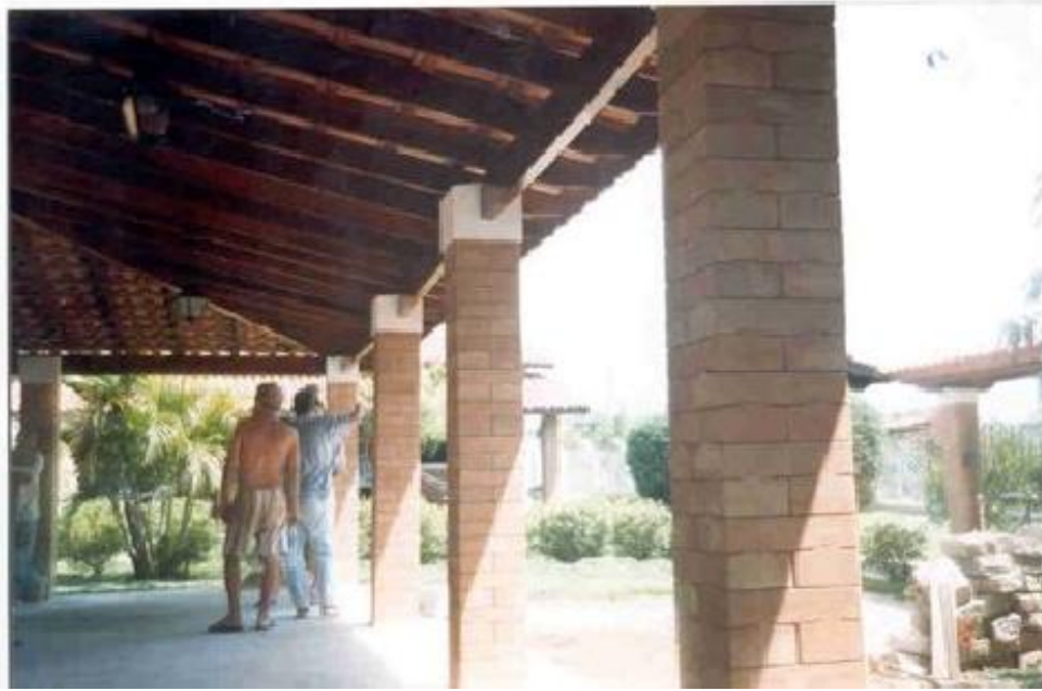
Figura 7. Vista dos pilares da varanda.
