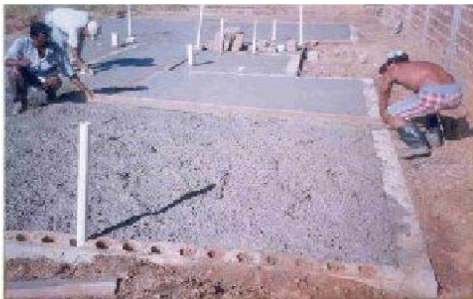
Figura 1. Concretagem do contrapiso.
