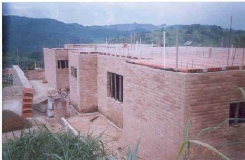
Figura 5. Colocação das lajotas da laje.
