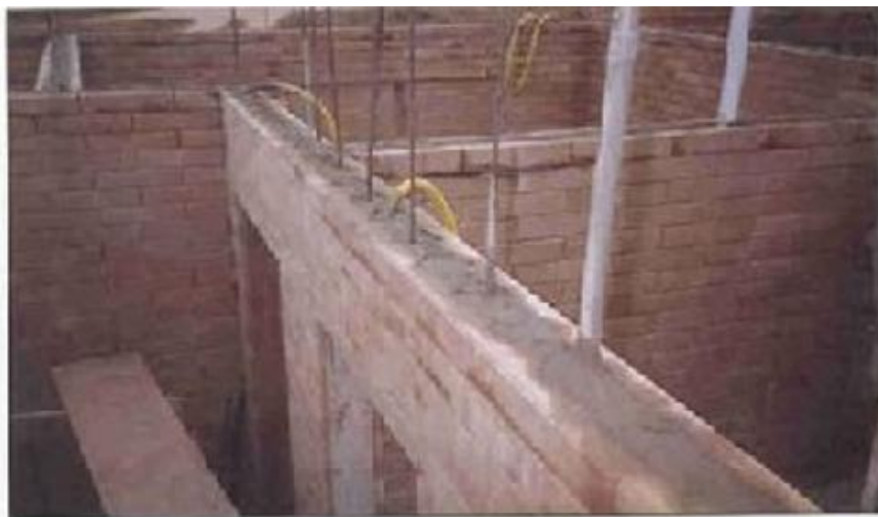
Figura 3. Respaldo da alvenaria e passagem das tubulações.
