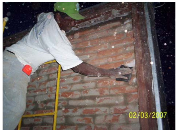
Figura 3.22 Acabamento na superfície da parede.
