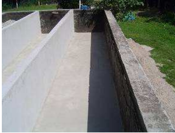
Figura 10 – Adaptação da lagoa de polimento para leitos cultivados.
