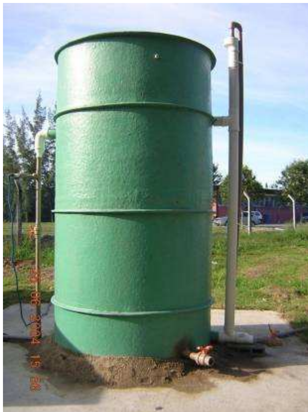
Figura 4 – Reator Anaeróbio Compartimentado (RAC).
