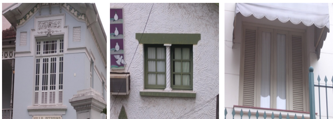
Figura 33: janelas com a utilização do vidro no séc. XIX.
