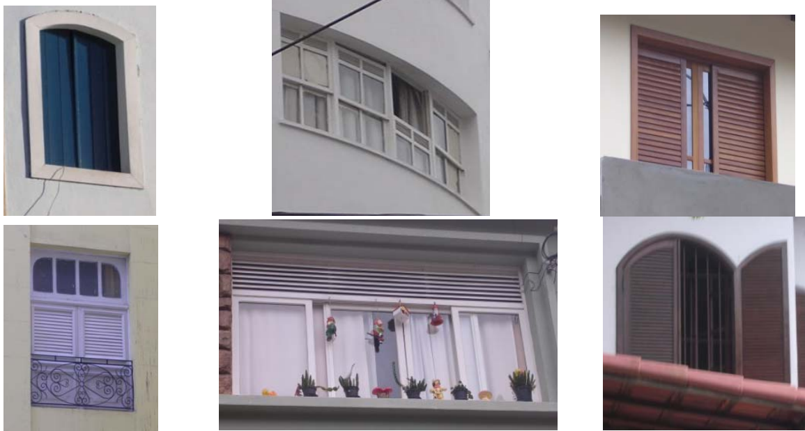
Figura 34: algumas tipologias de janelas em madeira utilizadas no decorrer da história do estado do Espírito Santo.
