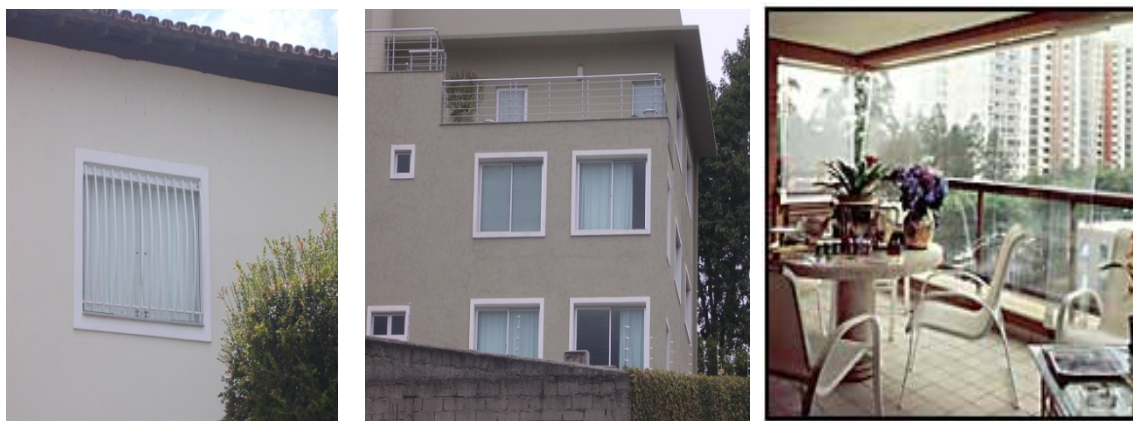
Figura 30: janelas em vidro e ferragens metálicas.
