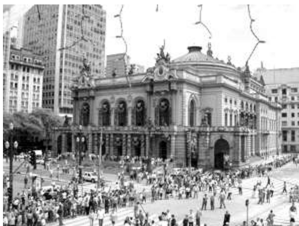
Figura 25: janelas em ferro. Theatro Municipal de São Paulo.
